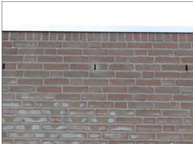
Figuur: het gebouw bevat meerdere open stootvoegen. Open stootvoegen zijn geschikte invliegopeningen voor vleermuizen.
