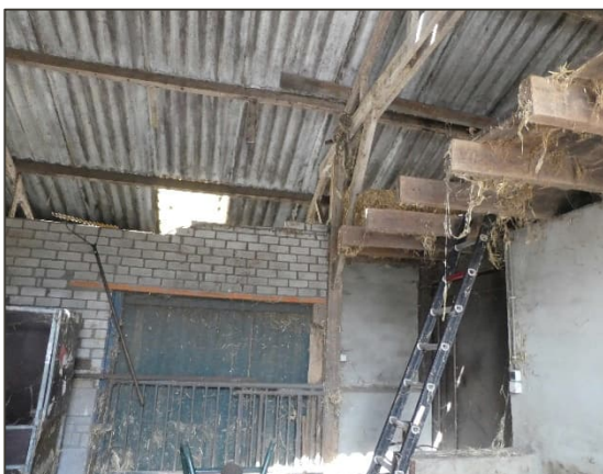
Afbeelding 6. Gebouw dat in gebruik is als opslagplaats en stalling van kalveren
