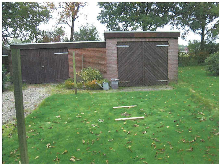
onderzoekslocatie - positie onder- grondse tank
