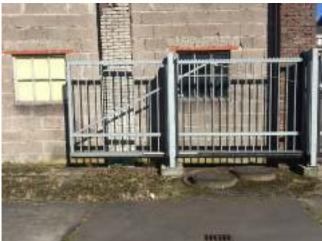
Foto 3, ligging vml ondergrondse tank achterzijde
