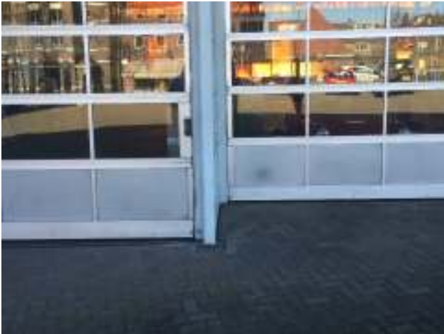
Foto 1, ligging vml ondergrondse tank voorzijde
