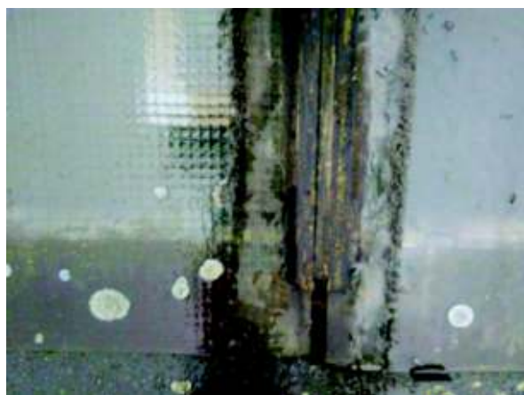
Ramen geen asbest
