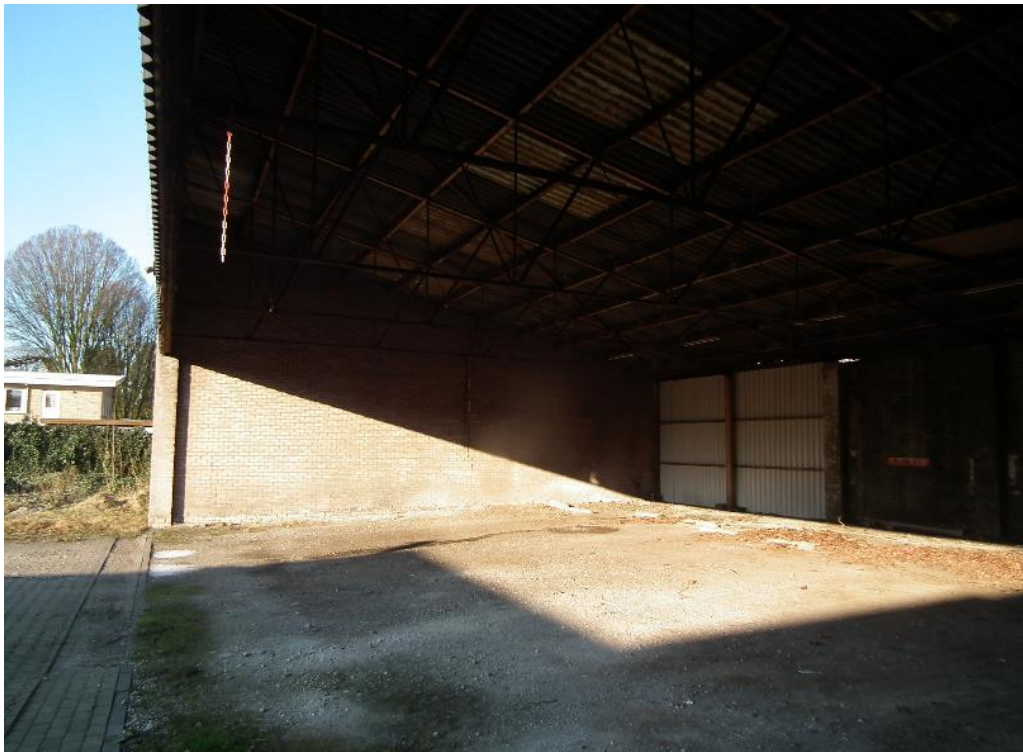
Figuur 3 Aan de achterzijde op het perceel is een stallingsloods aanwezig.
