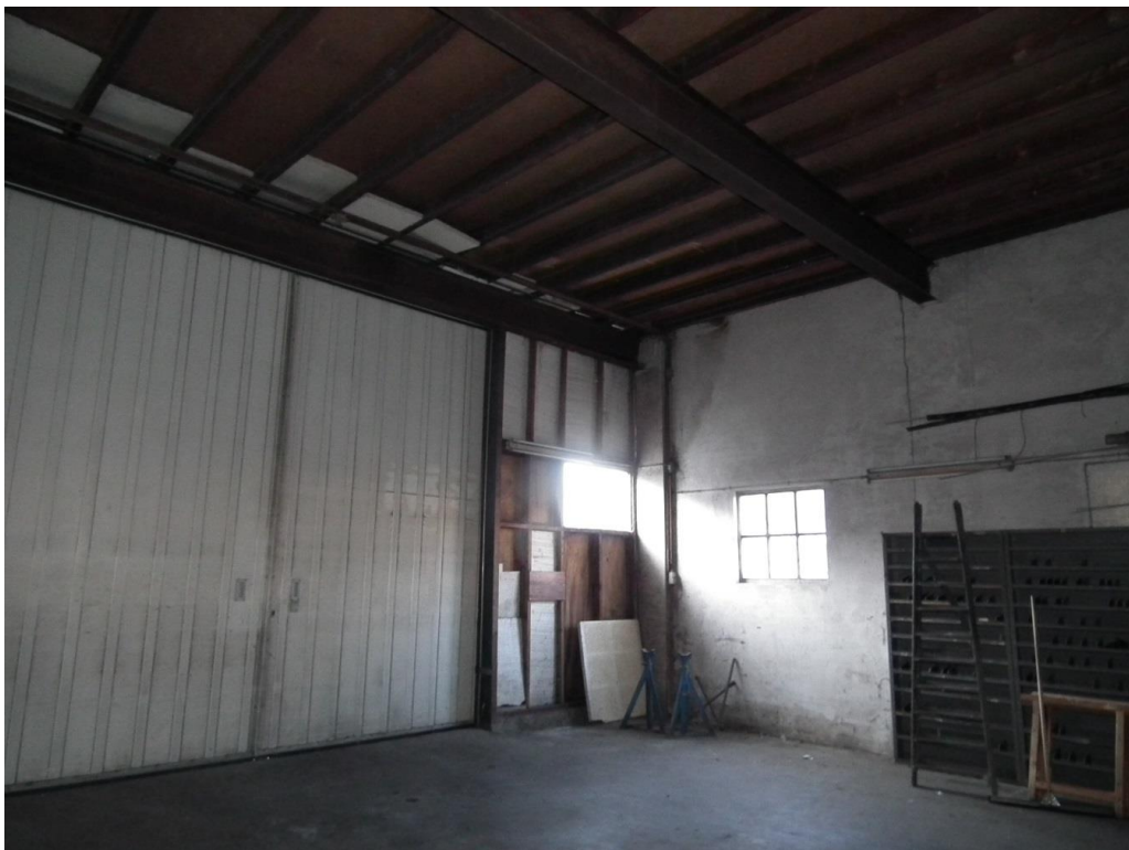
Figuur 4 De meeste gevels en muren van het garagepand zijn volgestort met beton.
