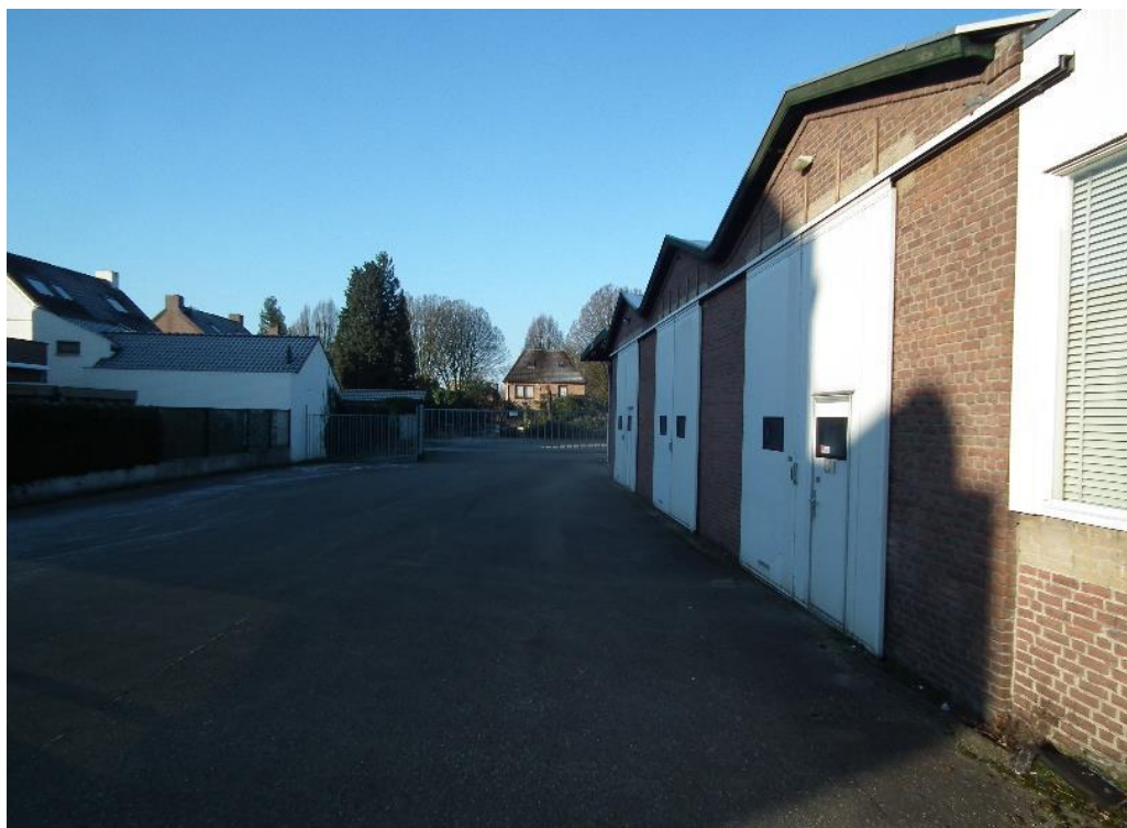
Figuur 2 Een gedeelte aan de zuidzijde van het gebouw is opgetrokken uit gemetselde muren en een bitumen zadeldak.
