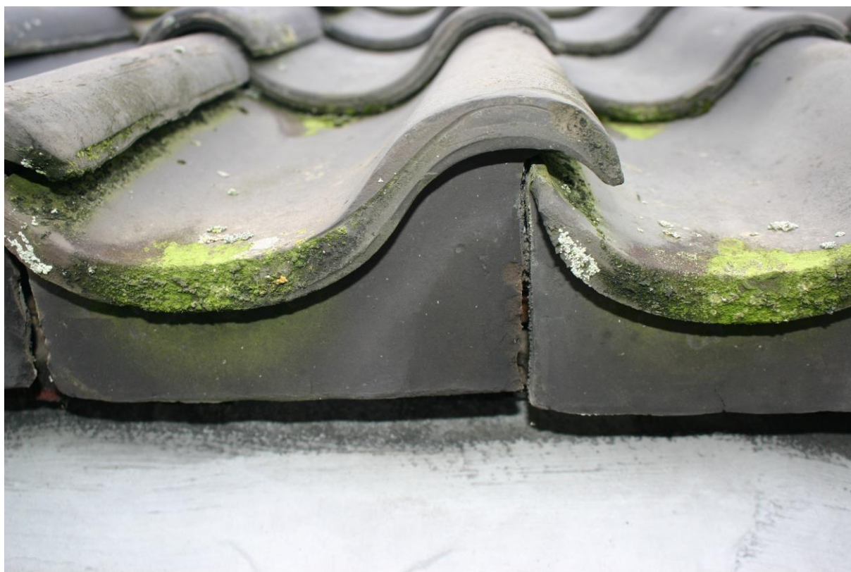
Figuur 4. Onder de onderste dakpannen is geen ruimte voor huismussen aanwezig.
