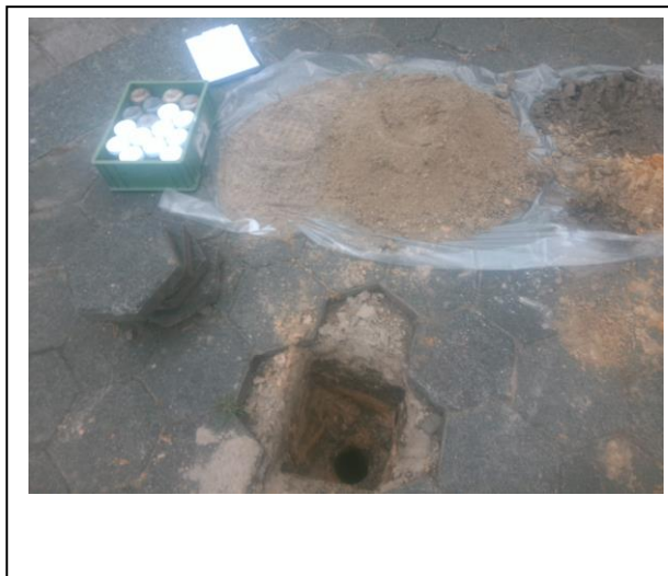
Foto 4. Asbestinspectiegat 05
