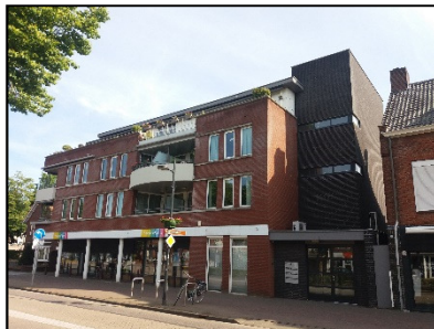
Figuur 4. Voorzijde reisbureau en bovenwoningen.
