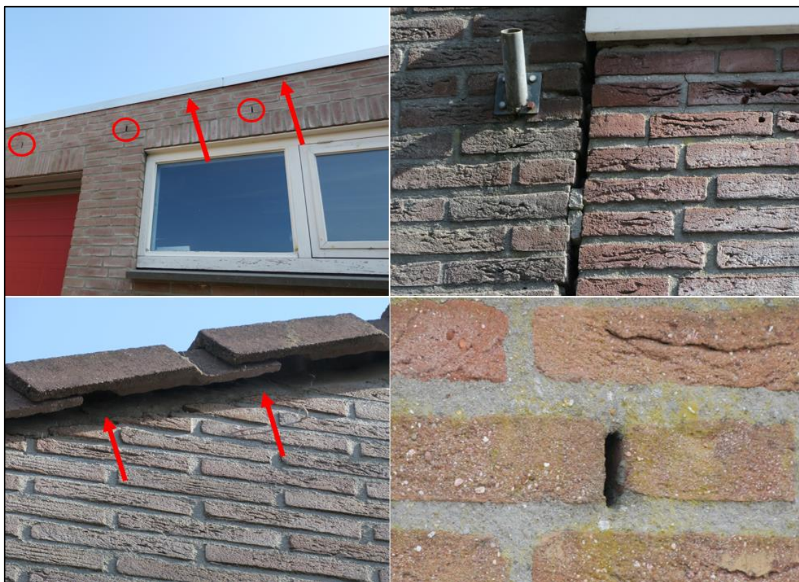
Figuur 3.1 Enkele voorbeelden van openingen op de planlocatie welke vleermuizen mogelijk kunnen gebruiken om een verblijfplaats te bereiken.
