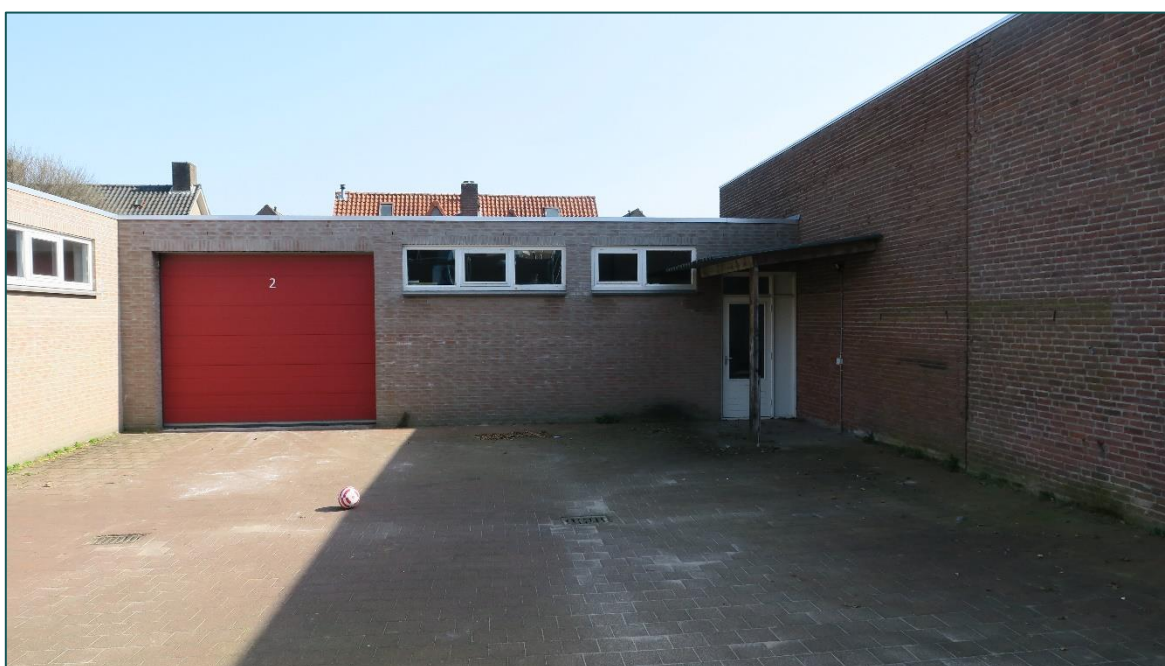
Figuur 4 De binnenplaats van het stucadoorsbedrijf (gebouw A).
