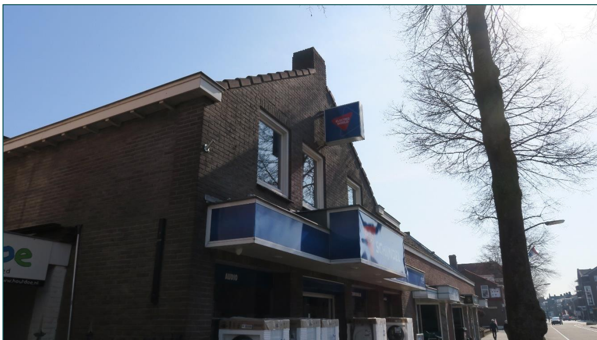
Figuur 3 Overzicht van de elektronicazaak (gebouw F). Gezien de boom op voldoende afstand van het pand staat is er een vrije aanliegroute voor de gierzwaluw aanwezig en dient dit pand onderzocht te worden op de aanwezigheid van nestlocaties gezien de kierende kantpannen.
