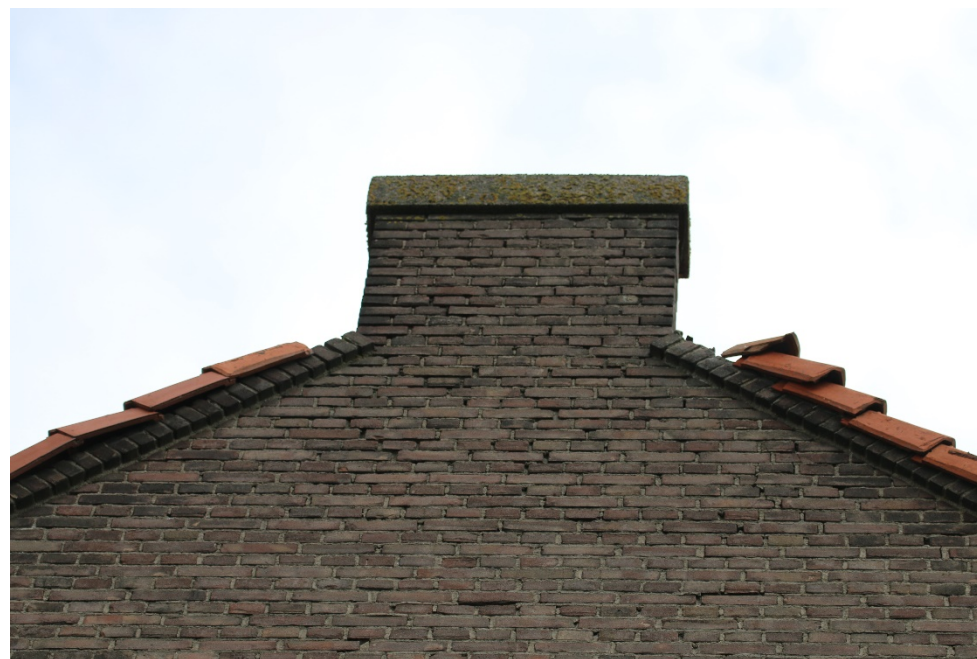
Figuur 14. Er zijn diverse openingen aanwezig waarbij vleermuizen de ruimte onder de dakpannen kunnen bereiken.
