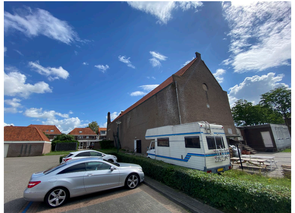
Figuur 6. Beeld van achter- en westgevel.
