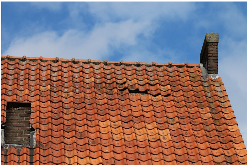
Figuur 11. In de oostzijde van het dak zijn op diverse plekken openingen aanwezig in het dak. Deze openingen bieden toegang voor huismus, gierzwaluw en vleermuizen.
