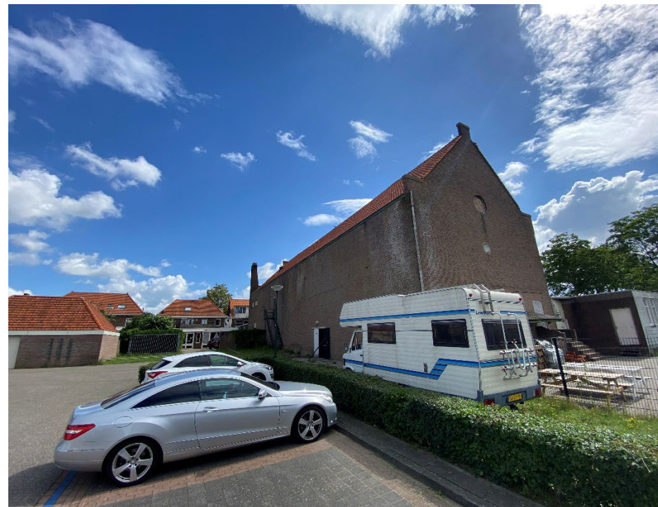
Figuur 6. Beeld van achter- en westgevel.
