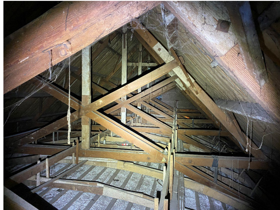
Figuur 8. Beeld van de zolder van het gebouw. Er zijn hier in het geheel geen sporen van vleermuizen aangetroffen.
