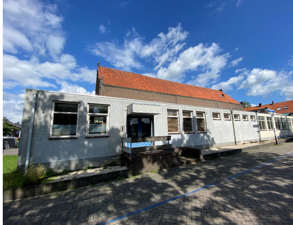
Figuur 5. Beeld van de oostgevel.
