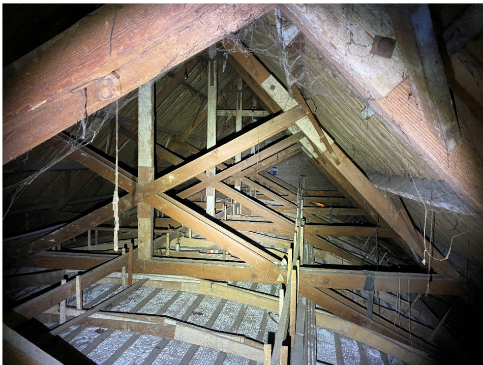
Figuur 13. Beeld van de zolder van het gebouw. Er zijn hier in het geheel geen sporen van vleermuizen aangetroffen.
