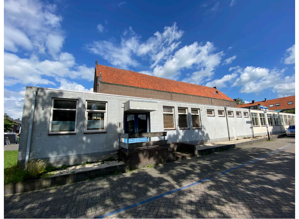
Figuur 5. Beeld van de oostgevel.
