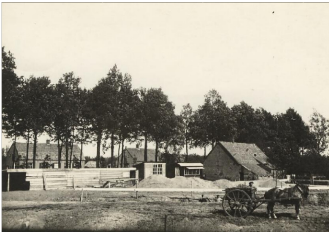
Figuur 29: Foto tijdens de bouw van de kerk in 1928. Bij de bomenrij ligt de Boschweg (Heemkundekring Schijndel 2019).
