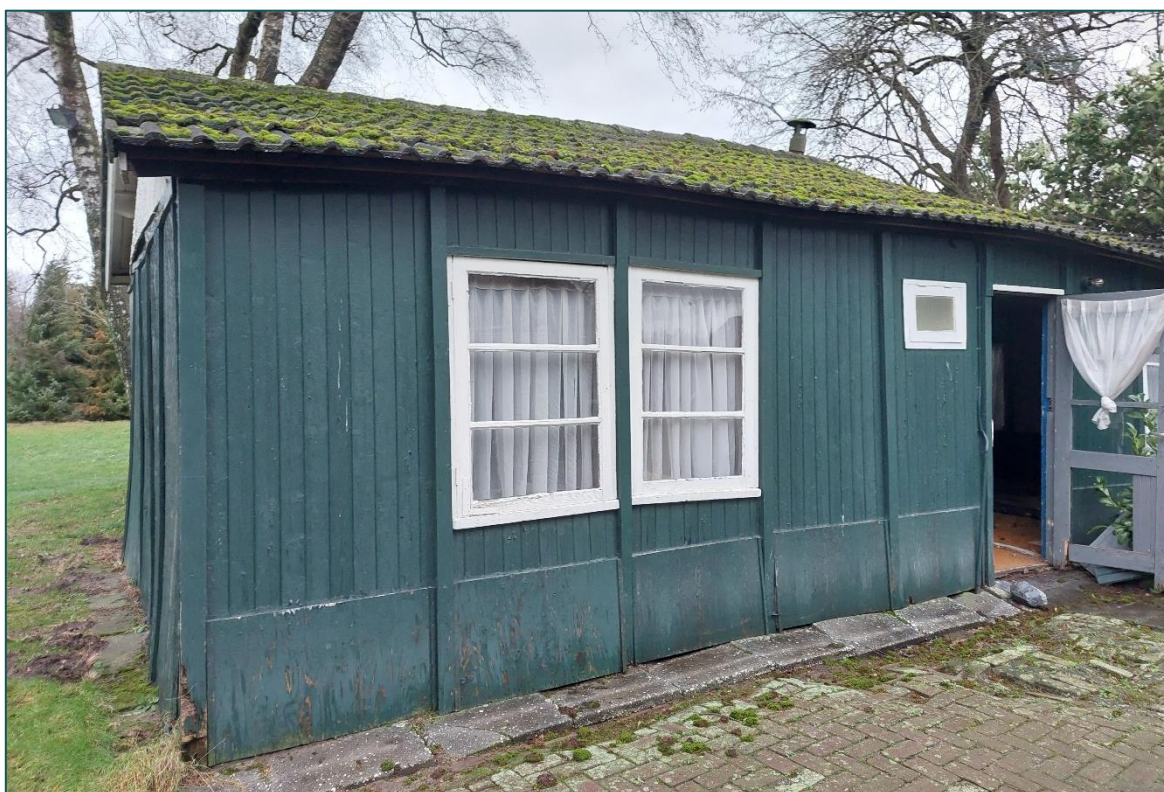
Figuur 3 De voorzijde van de voormalige woning (gebouw 2).
