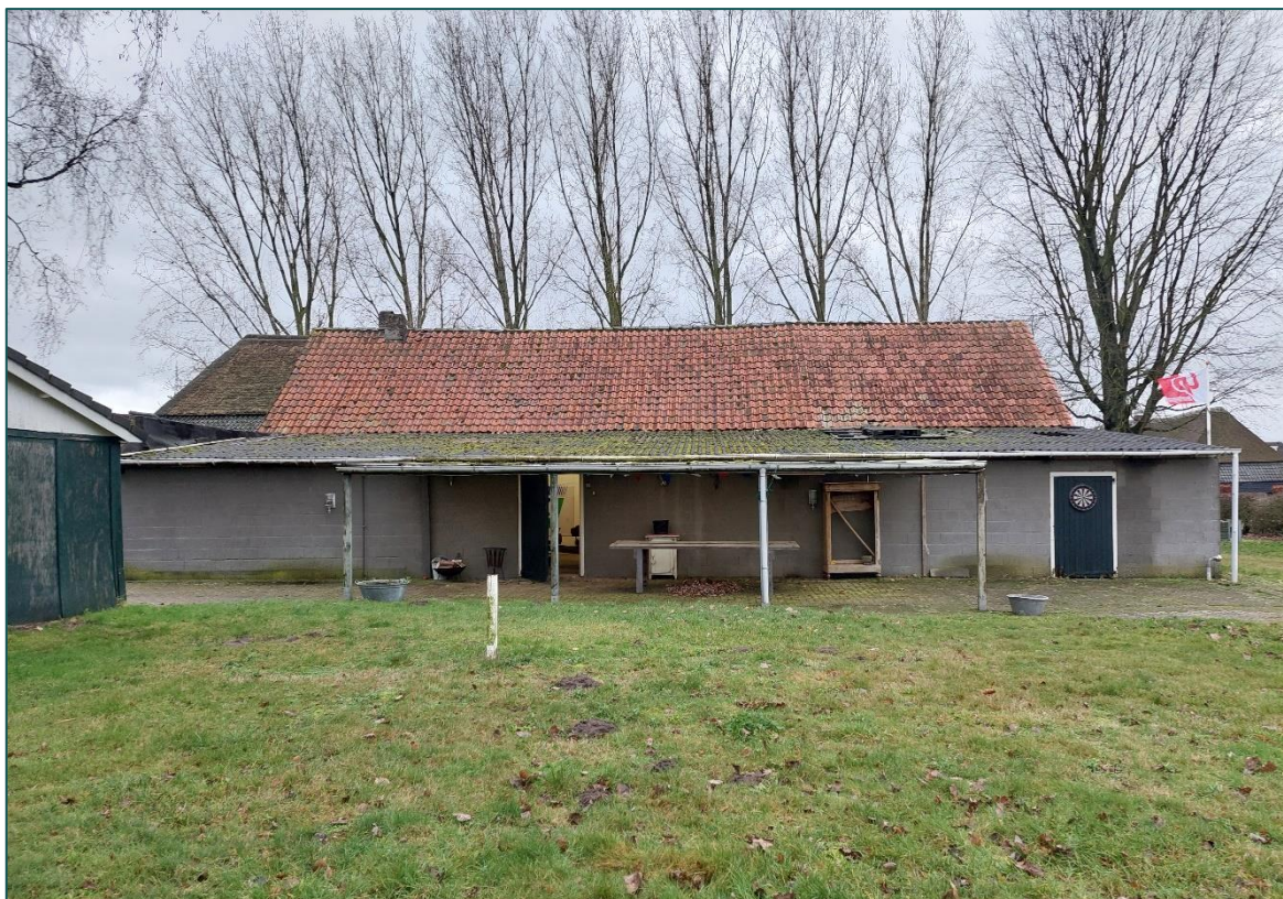
Figuur 2 De achterzijde van de te slopen schuur (gebouw 1).
