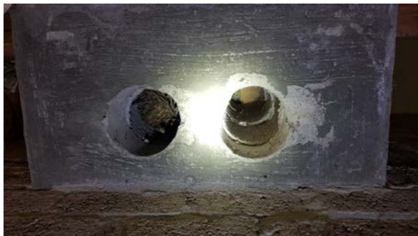
Rookkanaal onderzocht, niet asbestverdacht
