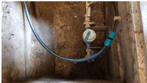
Watermeter onderzocht, niet asbestverdacht
