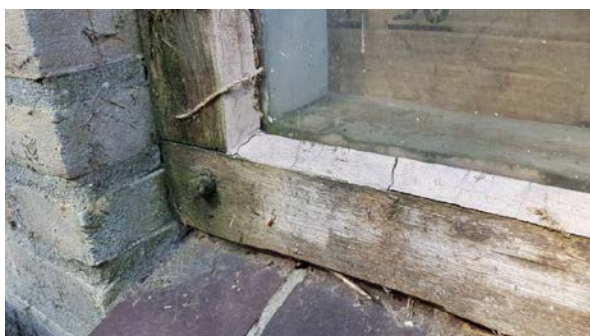
Stopverf onderzocht, niet asbestverdacht
