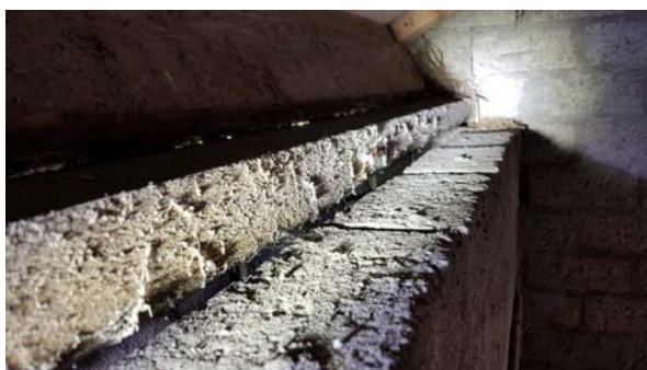
Op spouwmuur onderzocht, geen asbestverdachte muurplaat aangetroffen
