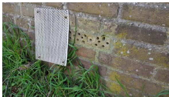
Ventilatie onderzocht, niet asbestverdacht
