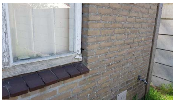
Spouwmuur naast kozijnen onderzocht, geen asbestverdachte materialen aangetroffen
