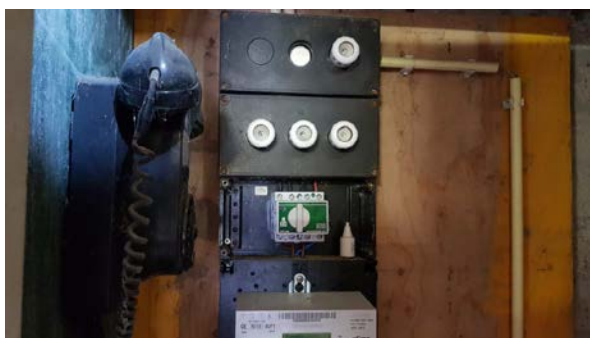
Meterkast onderzocht, geen asbestverdachte materialen aangetroffen
