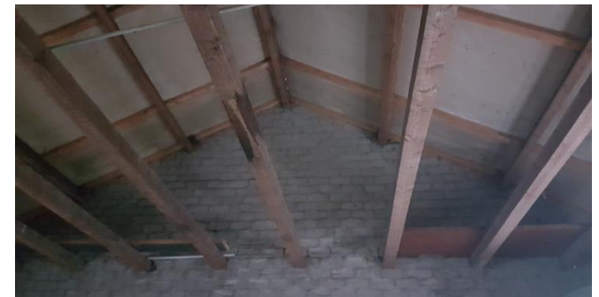
Figuur 6: Binnenkant schuur
