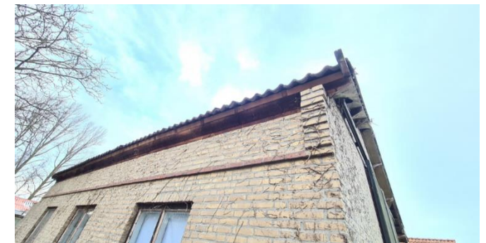
Figuur 6: Detailopname dakrand
