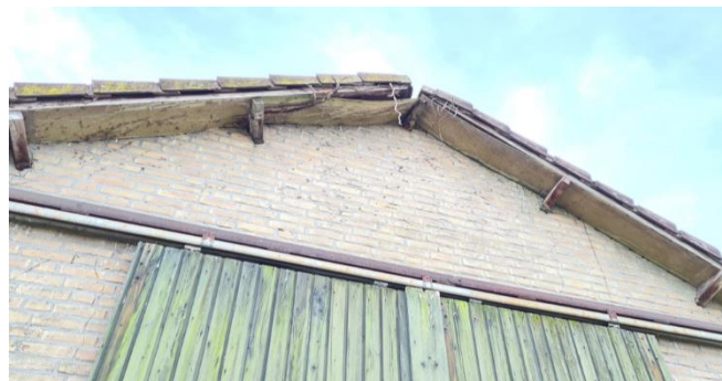
Figuur 5: Detailopname dakrand
