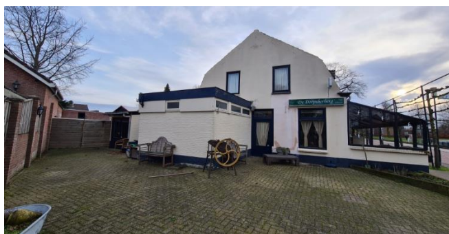
Figuur 7: Zijkant 'De Dorpsherberg' gezien vanaf Pastoor Smitsstraat
