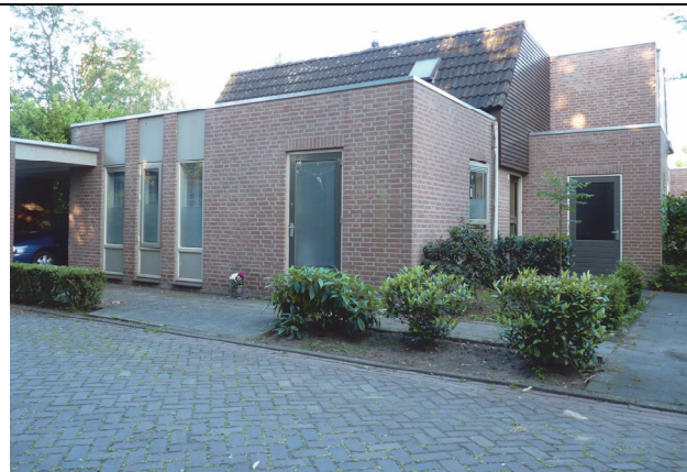
Fig. 5. Overzicht deel plangebied. Foto genomen richting het westen.
