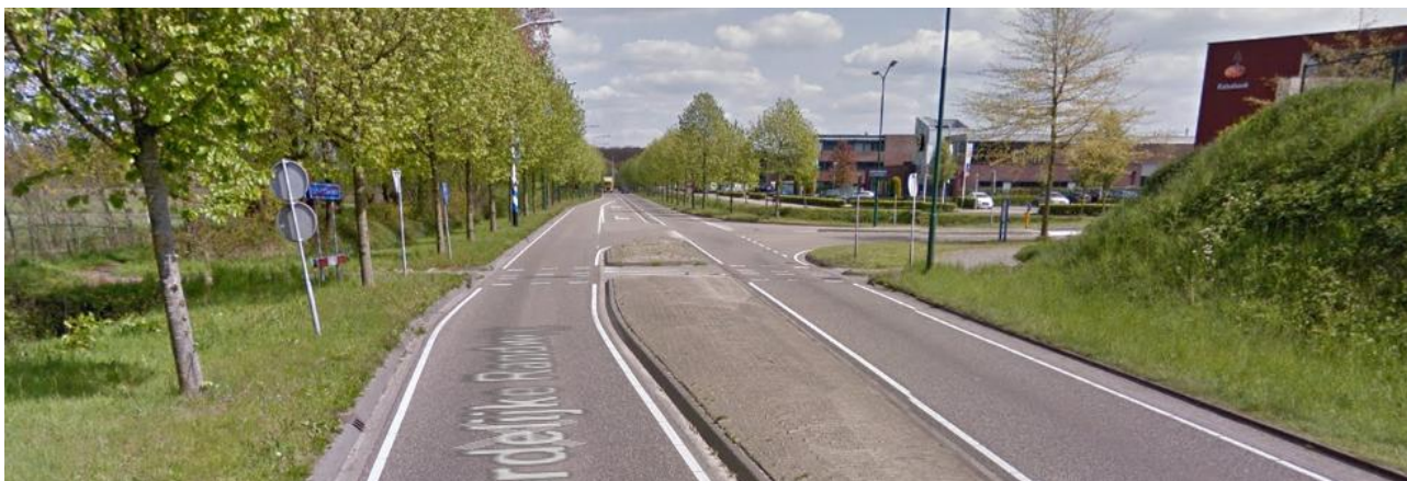
Figuur 18: Geluidswal en zicht op het kruispunt Noordelijke Randweg – Marie Curiestraat
