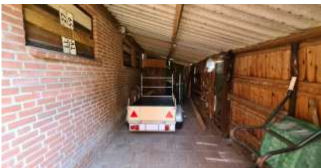
Figuur 7: Binnenzijde schuur
