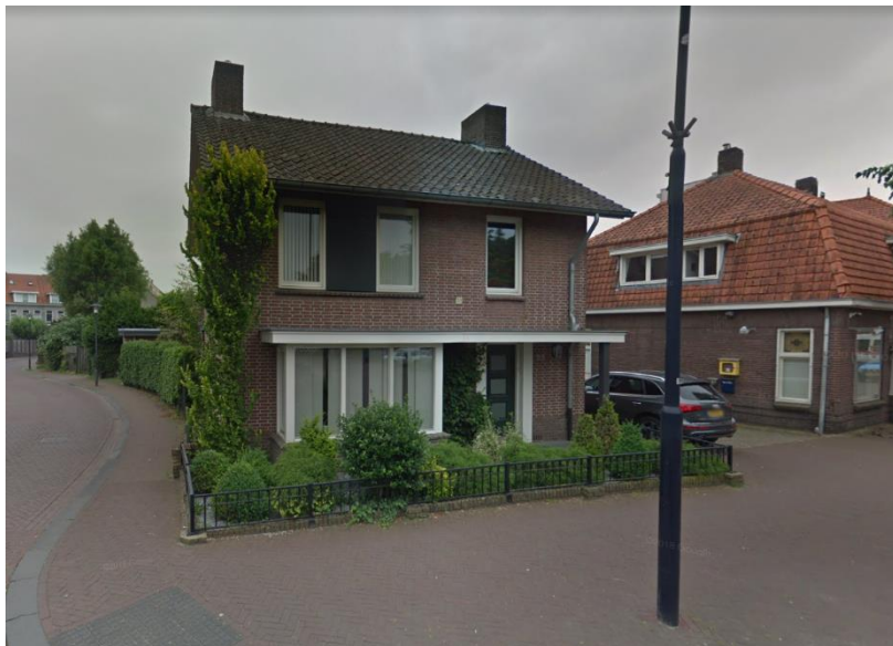
Afbeelding 2.6: Woning Borchmolendijk 22, gezien vanaf de gelijknamige weg (Bron: Google Streetview)
