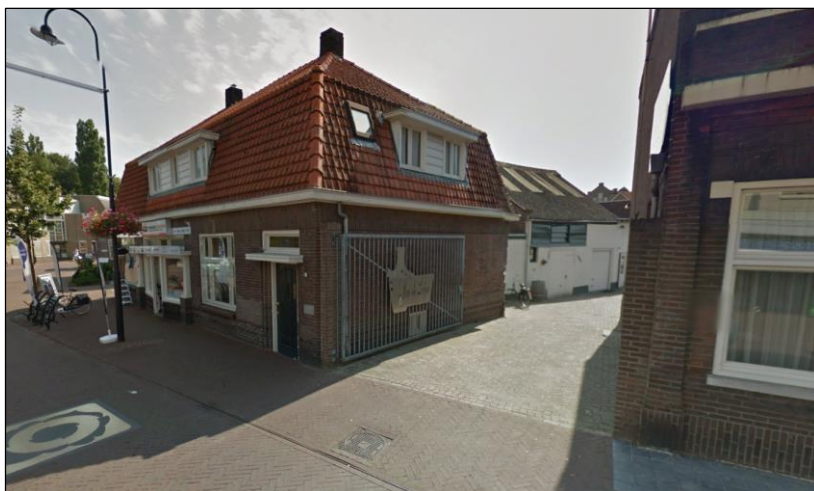
Afbeelding 2.2: De panden aan de Borchmolendijk 18 en 20 (Bron: Google Streetview)
