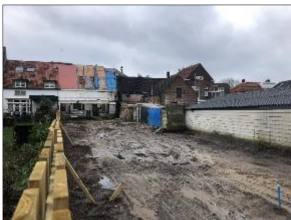
Figuur 8. In winter bouwrijp gemaakte achtertuin van Borchmolendijk 12/12a
