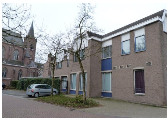
Fig. 5. Buitenzijde bankgebouw aan zijde parkeerterrein
