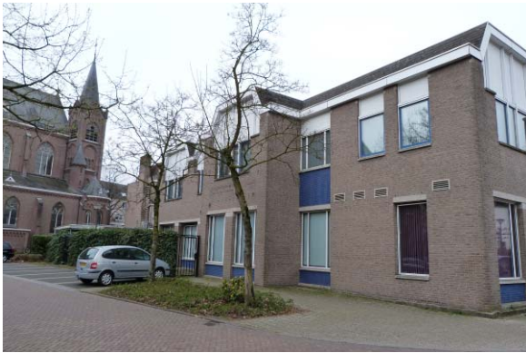
Fig. 5. Buitenzijde bankgebouw aan zijde parkeerterrein
