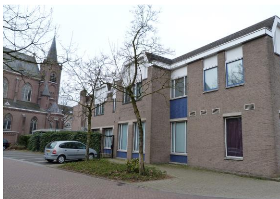
Fig. 5. Buitenzijde bankgebouw aan zijde parkeerterrein
