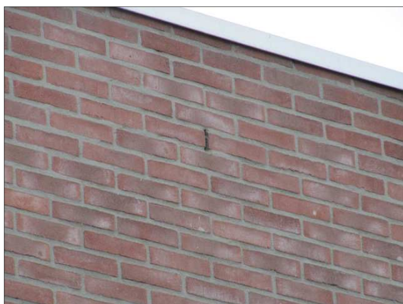
Figuur 14. Geschikte opening/potentiële verblijfplaats voor vleermuizen.
