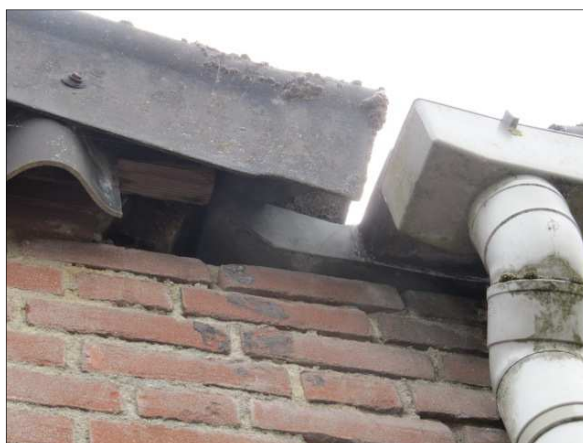
Figuur 15. Geschikte opening/potentiële verblijfplaats voor vleermuizen.
