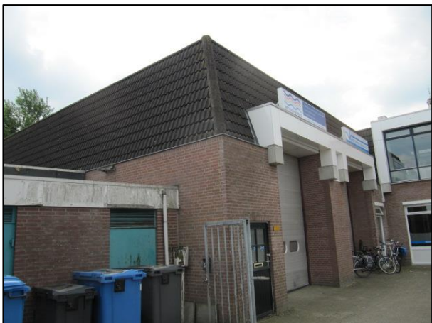
Figuur 5. Meest westelijke gebouw
