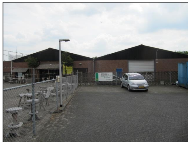
Figuur 4. Noordzijde loodsen
