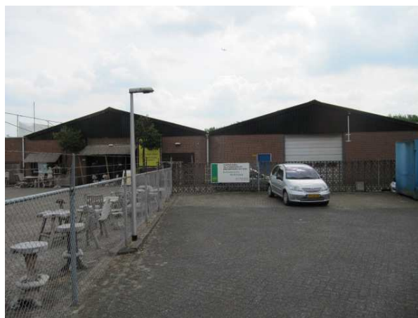
Figuur 4. Noordzijde loodsen.
