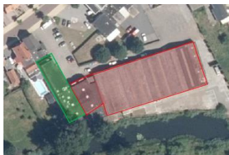
Figuur 23: Te slopen bedrijfshallen, te behouden kantoor
