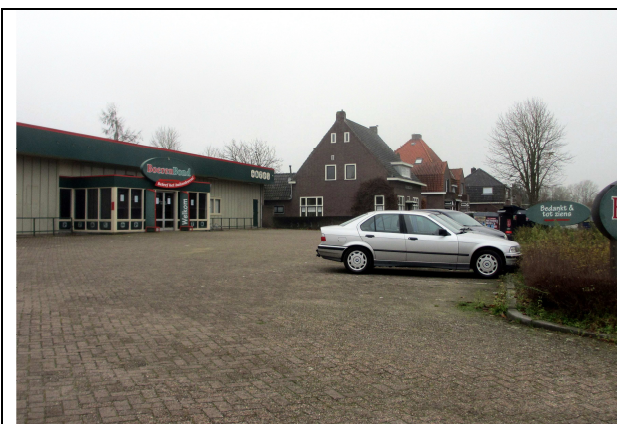
Fig. 3. Overzicht van de entree van de voormalige Welkoop
