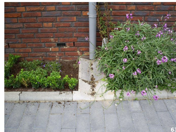
oplossing infiltratie hemelwater
