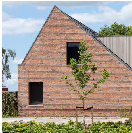
Kopgevels naar de (Dahlia)straat
