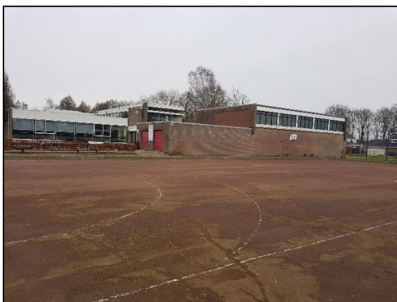
Figuur 7. Pekveld en gymzaal in zuiden plangebied
