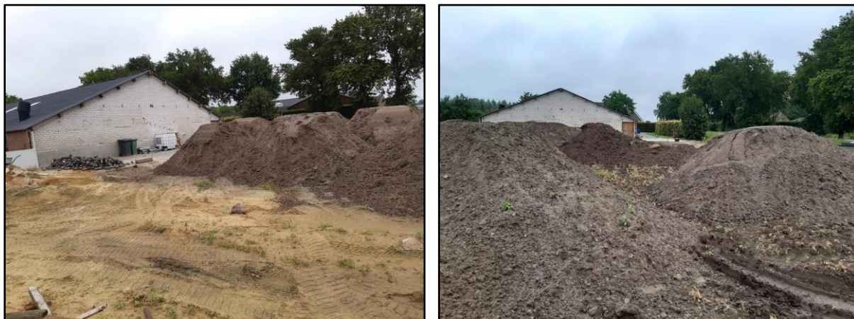
Afbeelding 17: foto's sloop varkensstallen
