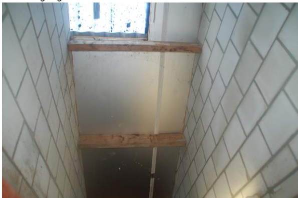
binnenzijde stal 3 met geïsoleerd dak
