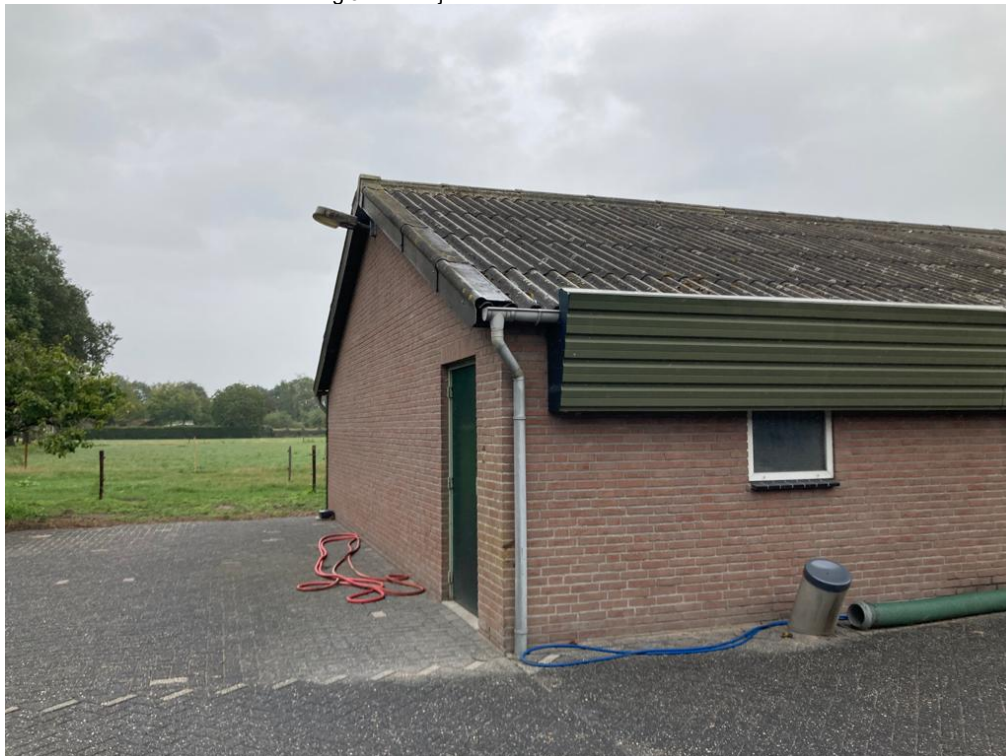
• Afbeelding 9: buitenzijde varkensstal met luchtinlaat
