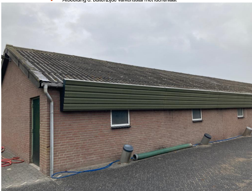
• Afbeelding 8: buitenzijde varkensstal met luchtinlaat
