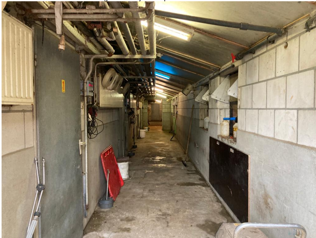
• Afbeelding 4: binnenzijde te slopen varkensstal
