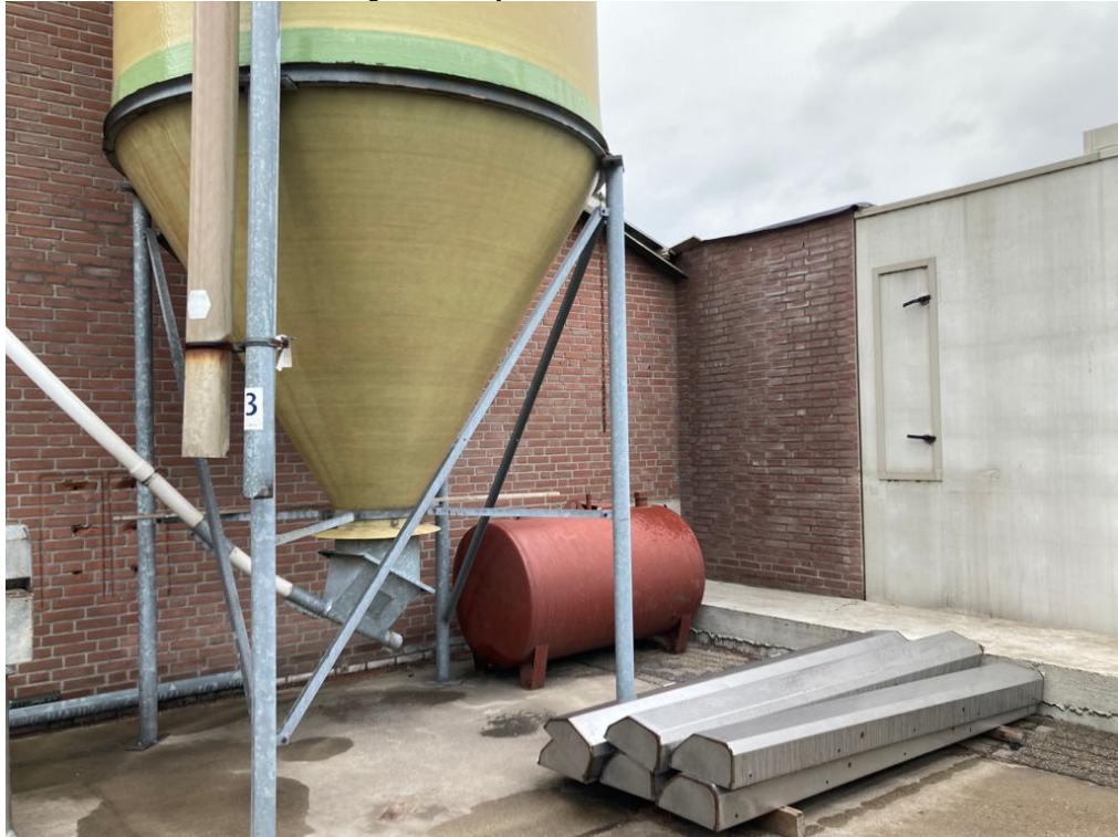
• Afbeelding 13: buitenzijde varkensstal met luchtwasser en voersilo
