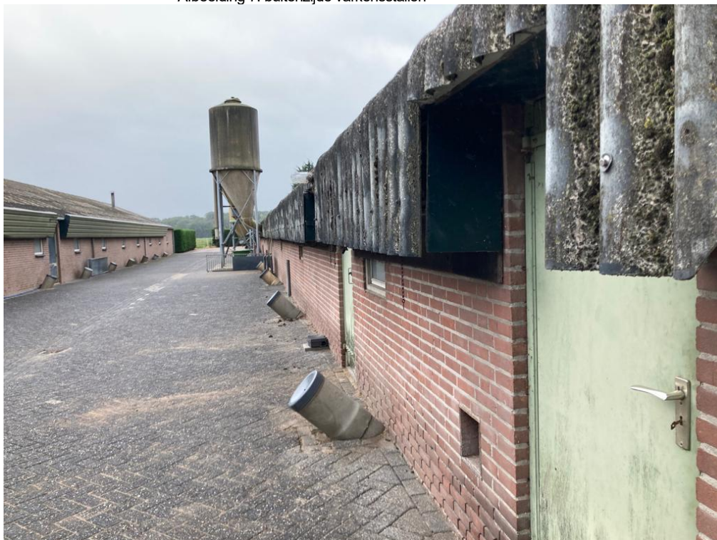
• Afbeelding 7: buitenzijde varkensstallen
