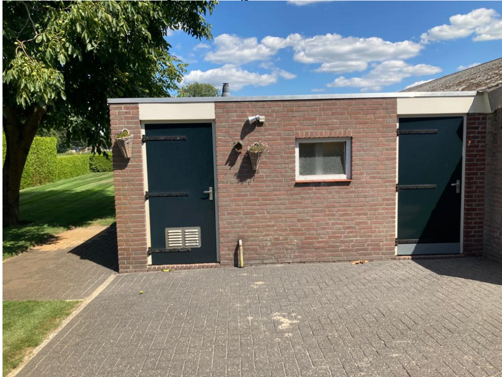
• Afbeelding 25: te slopen bijgebouw
