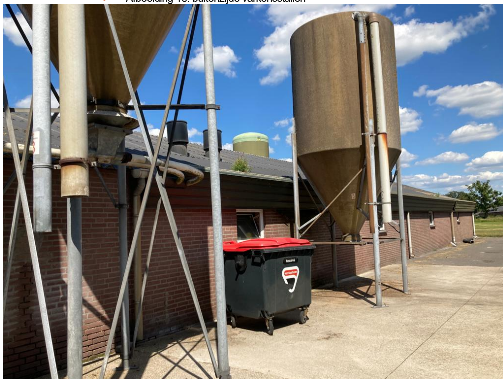
• Afbeelding 16: buitenzijde varkensstallen
