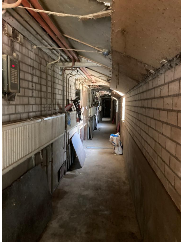
• Afbeelding 15: binnenzijde varkensstallen
