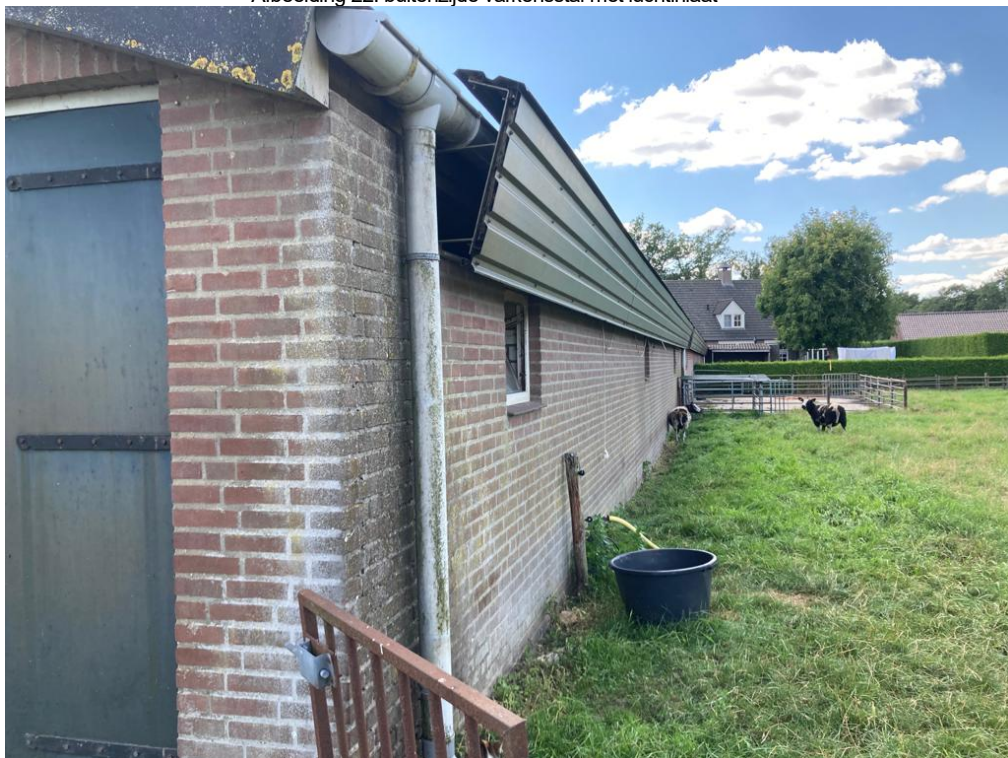
• Afbeelding 22: buitenzijde varkensstal met luchtinlaat
