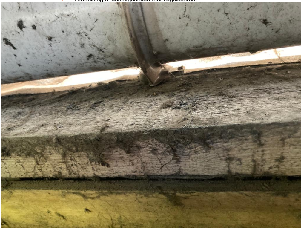
• Afbeelding 6: dak afgesloten met vogelschroot
