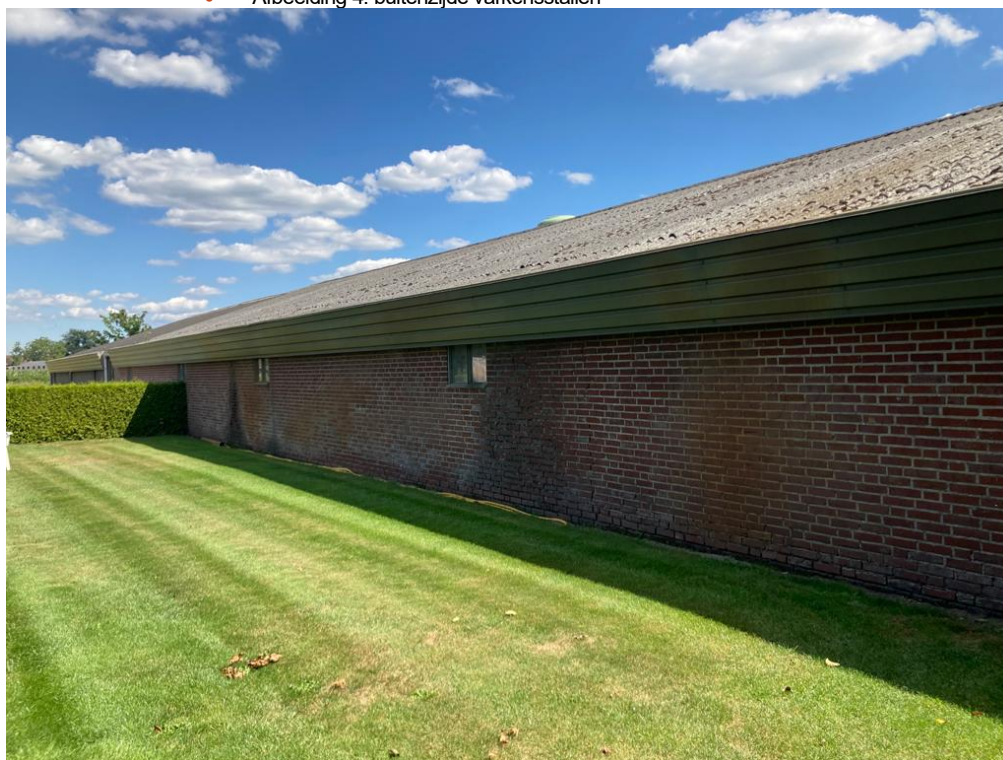
• Afbeelding 4: buitenzijde varkensstallen
