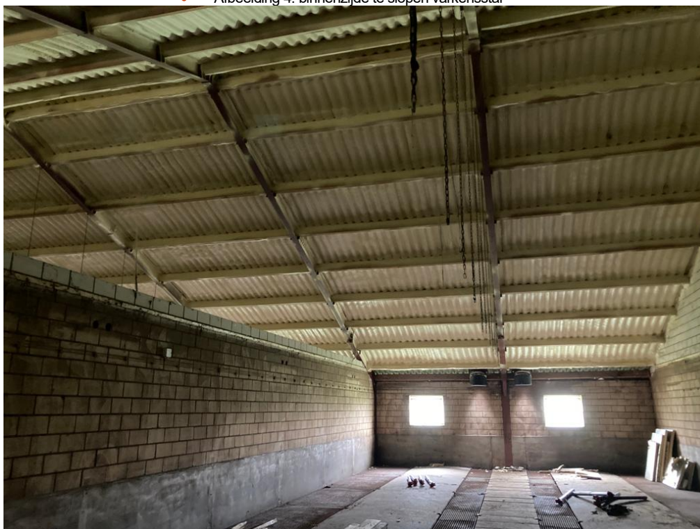
• Afbeelding 4: binnenzijde te slopen varkensstal
