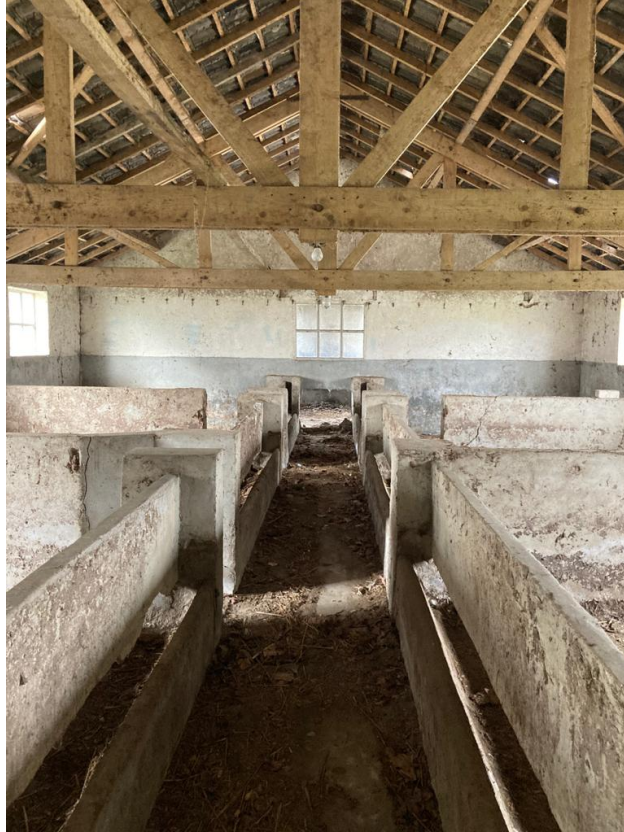
• Afbeelding 18: binnenzijde schuur die behouden blijft
