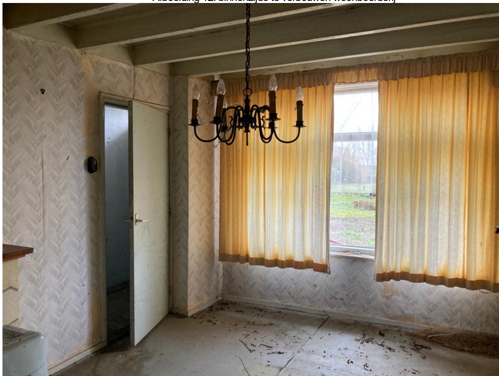
• Afbeelding 12: binnenzijde te verbouwen woonboerderij
