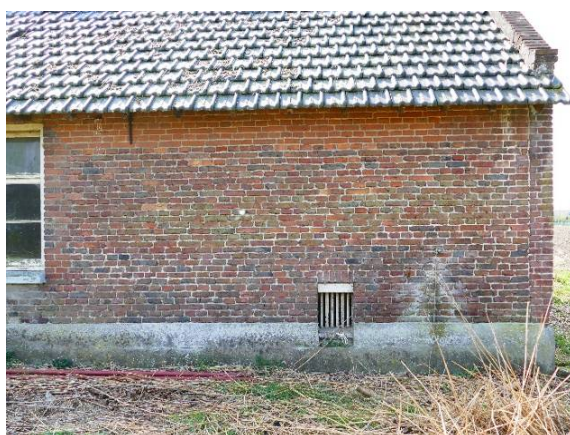
De gevel van de kelder/opkamer is in een afwijkende (oudere) steen in wildverband opgetrokken. Ook lijkt hij in een later stadium in kruisverband verhoogd te zijn.
