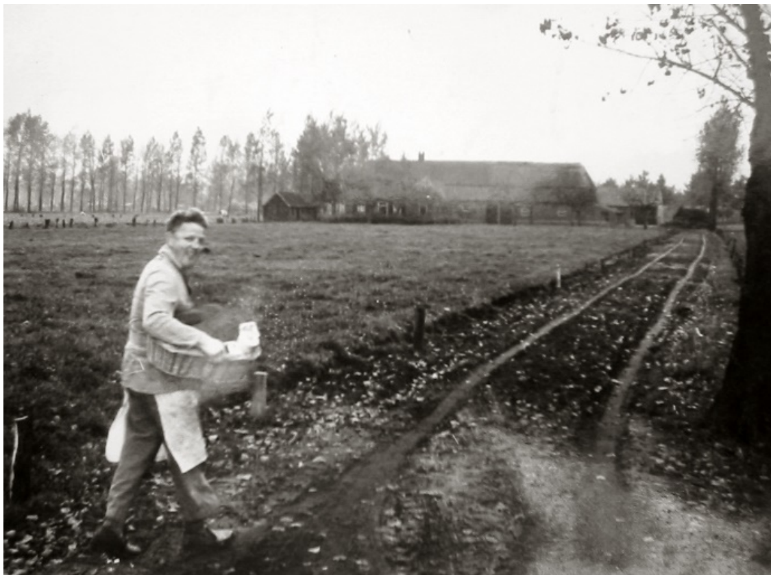
Krijtenburg 9 vóór de verbouwing van het woongedeelte. Het gebouwtje links voor is het bakhuis. De voordeur bevindt zich nog tussen de twee vensters. De stal is reeds verbouwd. Het schuurgedeelte heeft nog de grote deeldeuren met in het blinde gedeelte twee nieuwe stalramen. Op het erf staat een kippenhok en een varkensschuur. De huidige laan is nog een kale zandweg..
