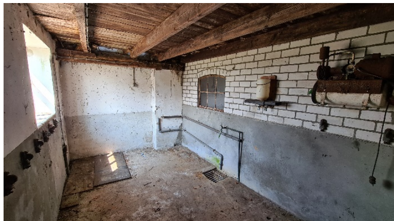
De melkkamer achter de brandgevel in de tussenruimte Geheel achter de trekbalk.
