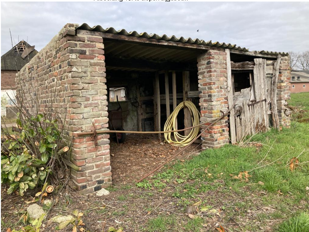
• Afbeelding 19: te slopen bijgebouw
