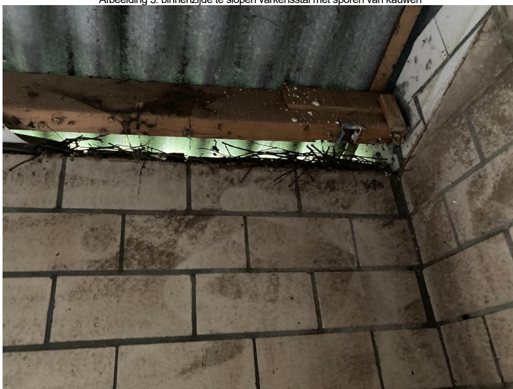
Afbeelding 5: binnenzijde te slopen varkensstal met sporen van kauwen
