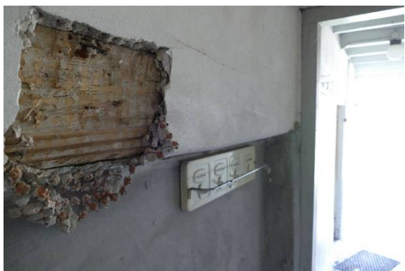
In de doucheruimte zit achter het stucwerk de originele schouw balk verborgen
