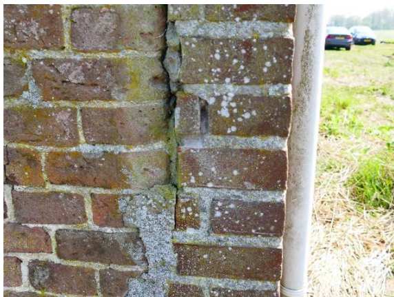
De nieuwe gevel staat voor de oude voorgevel.
