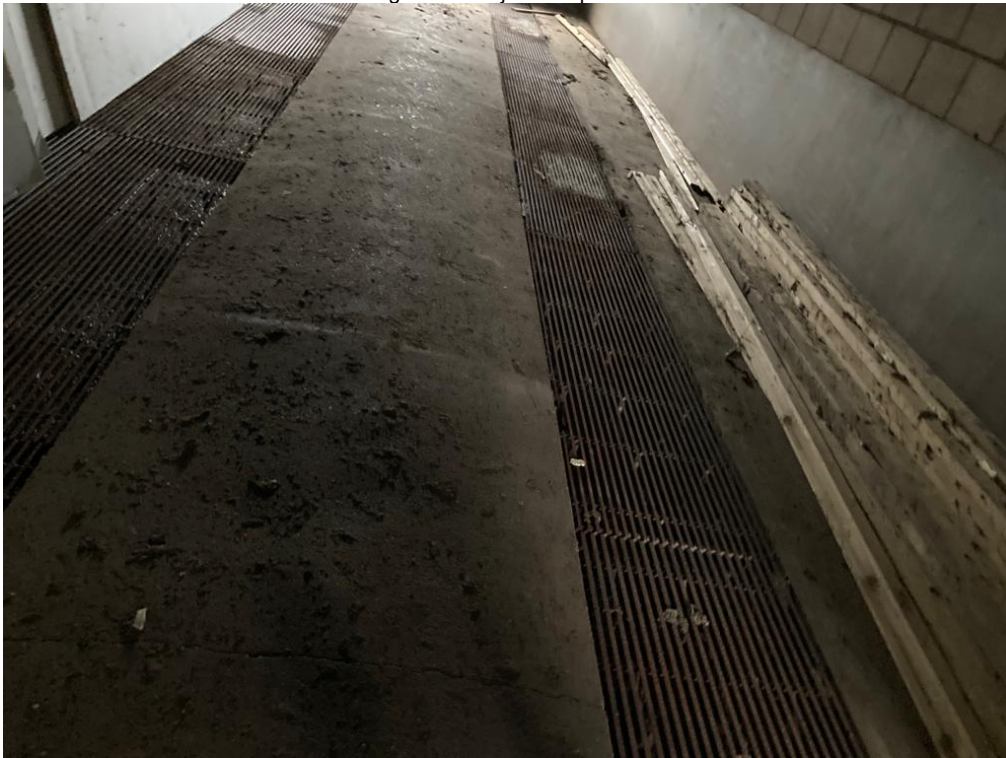
• Afbeelding 7: binnenzijde te slopen varkensstal
