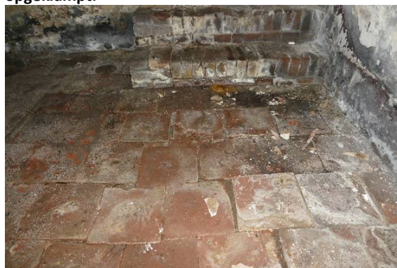
De stenen trap en plavuizenvloer van de kelder zijn geheel uit de bouwtijd.
