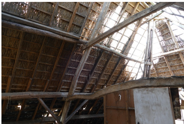
Bij het kapspant boven het woongedeelte is de onderste ligger naar boven gebogen. Dit waarschijnlijk om er gemakkelijker onderdoor te kunnen lopen.
