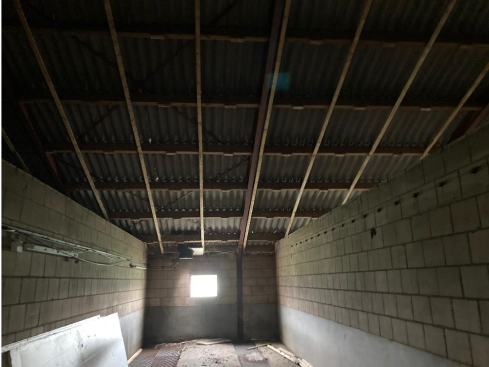
• Afbeelding 6: binnenzijde te slopen varkensstal
