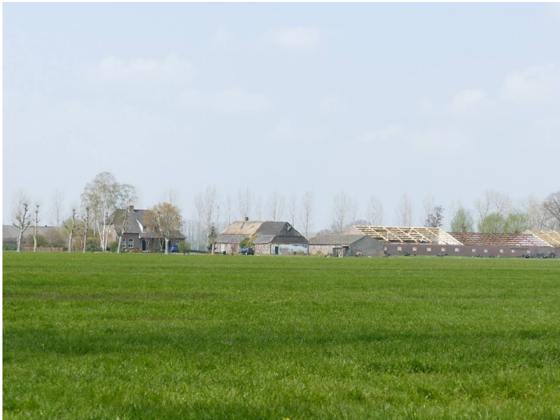
Onder: de sloop van de varkensstallen.
