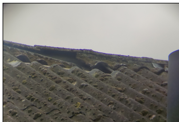
Foto 2 Opening in het dak aan de zuidoostzijde
