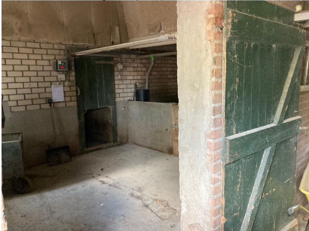
• Afbeelding 6: binnenzijde te slopen varkensstal
