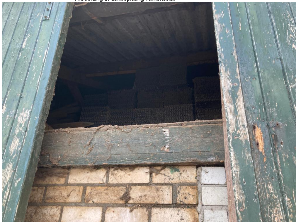
• Afbeelding 8: dakbeplating varkensstal
