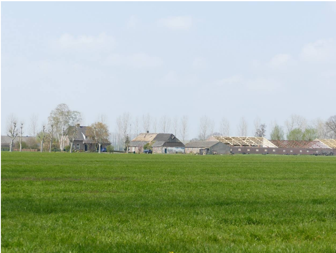
Onder: de sloop van de varkensstallen.
