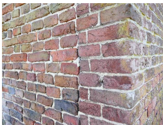
De kopgevel sluit met een loodvoeg aan op de gevel van kelder/opkamer.
