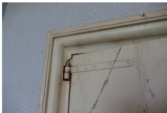
Deur met origineel hangwerk dat bevestigd is met hand gesmede nagels.
