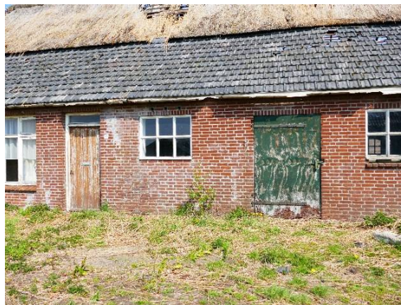
Overgang woongedeelte en stal
