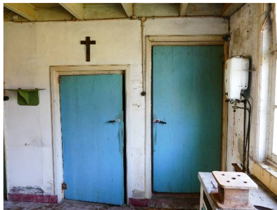
De originele deuren van kelder/opkamer zijn aan de zijde van de keuken vlak en aan de andere kant opgeklampt.
