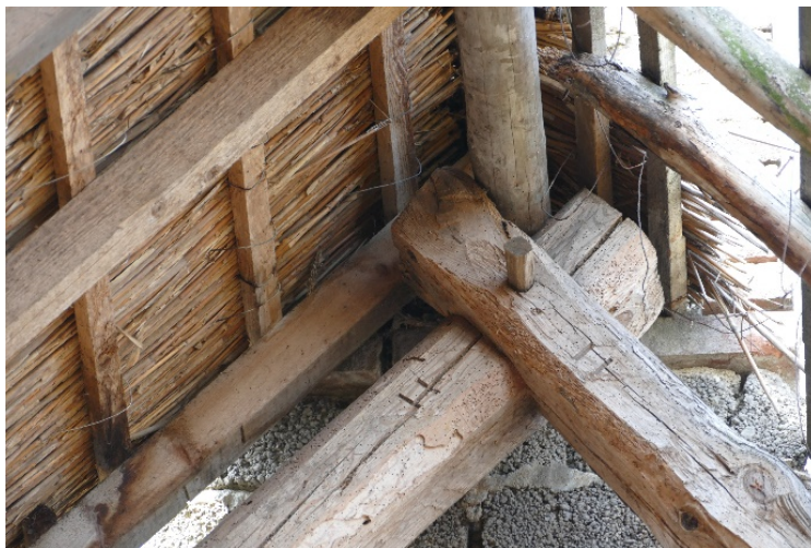
De top van het kaspant met de nokbalk. De beide spantbenen hebben het telmerk 2. Aan de linkzijde zijn de kasporen van gezaagd vuren. Aan de andere zijde van rondhout dennen.
