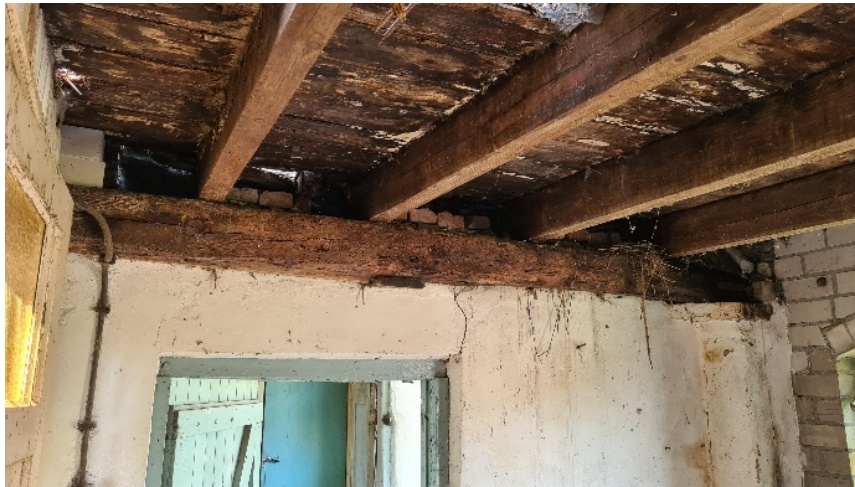
De eerste trekbalk ligt vlak achter de brandgevel.
