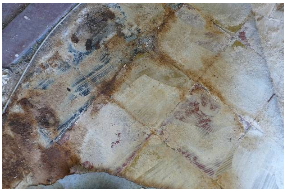
Onder het verlijmd tapijt in de huiskamer liggen de originele plavuizen.
