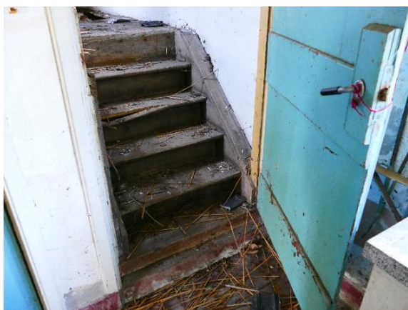
Boven: originele trap naar opkamer met de opgeklampte binnenzijde van de deur. Rechts: deur met opgeklampt paneel in een deftig kozijn.
