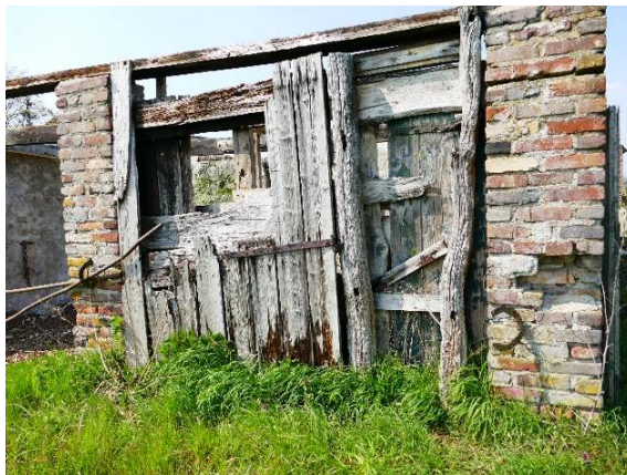
Op het erf bevindt zich nog het vervallen restant van een voormalig kippenhok. Het is later gebruikt als varkensschuur. Een tweede kippenhok bevond zich ter plaatse van het witte deel van de eindgevel van de boerderij.
