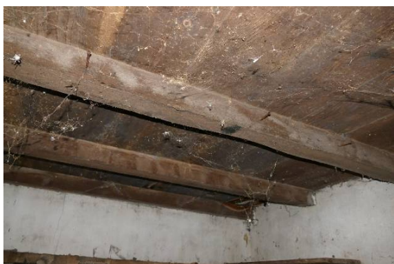
Het balkenplafond van de kelder heeft brede delen en is de vloer van de opkamer.
