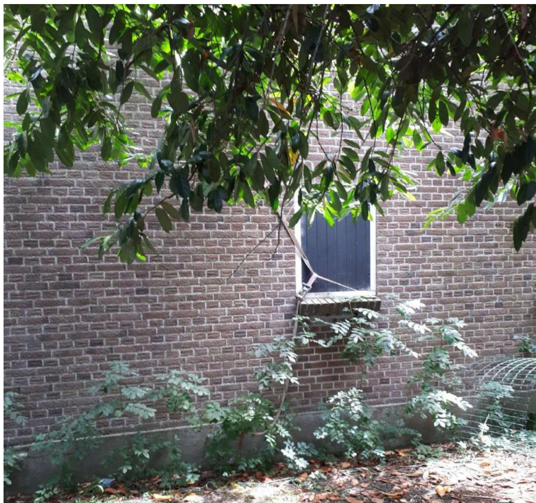
Figuur 13 - Detail westelijke gevel.
