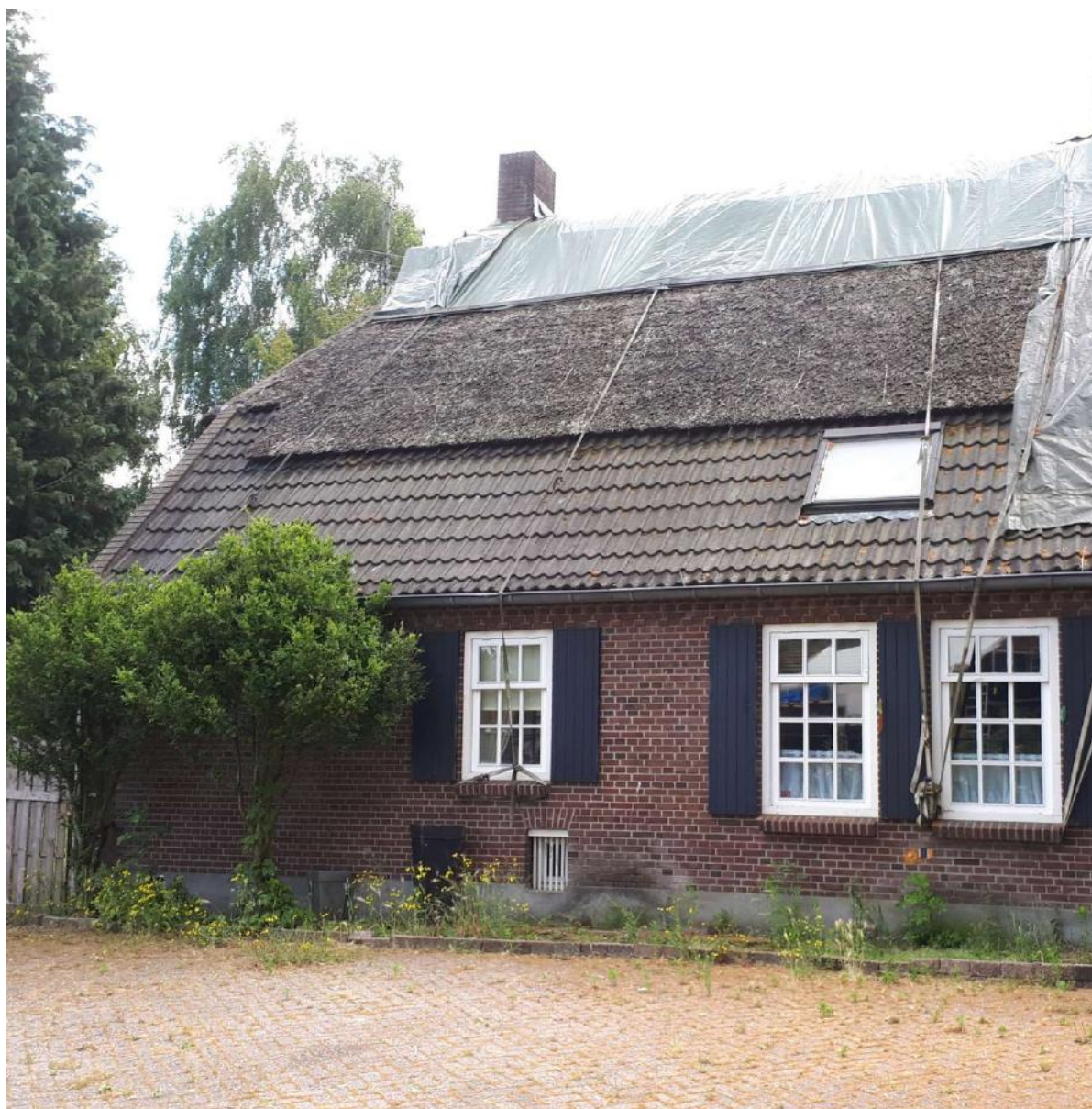
Figuur 1 - De voormalige agrarische bedrijfswoning; de rieten kap heeft ernstige schade opgelopen en is provisorisch gestabiliseerd.
