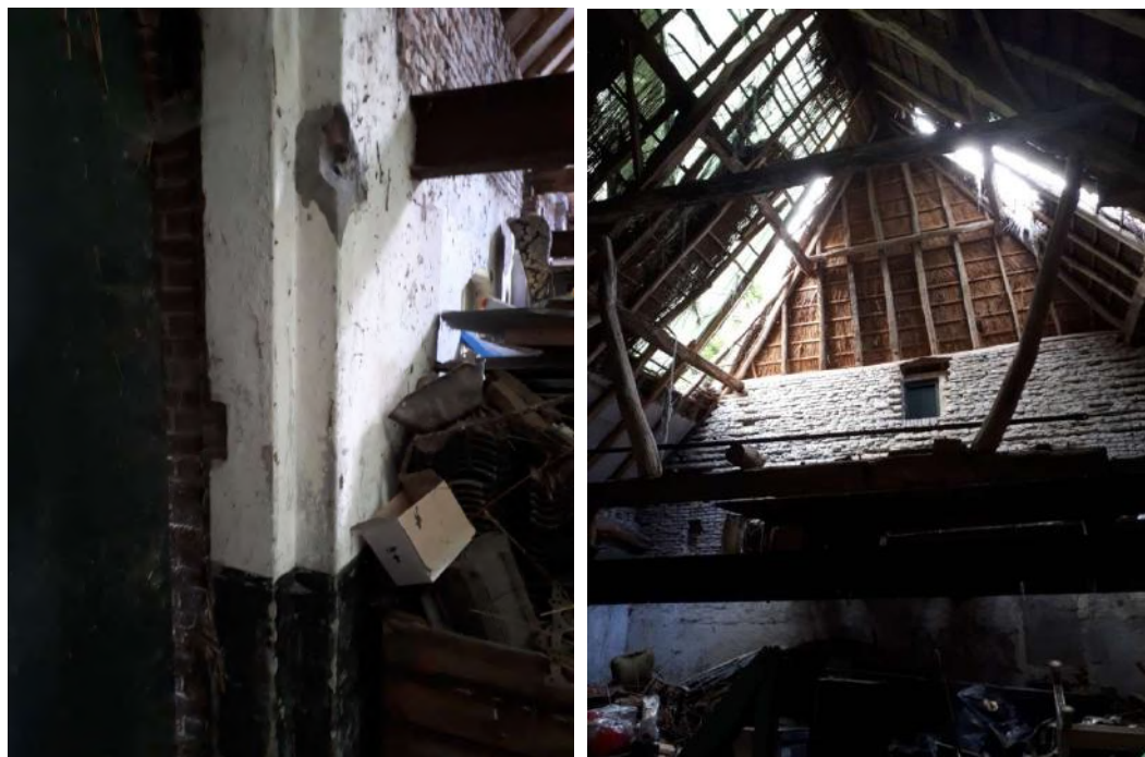
Figuur 12 - Links: de oorspronkelijke muur van de stal bij de toegangspoort; de doken van de poort hangen er nog steeds in; rechts is te zien dat de muur op enig moment is verhoogd. Rechts: in de westgevel zijn aan de binnenzijde nog diverse bouwsporen te onderscheiden.
