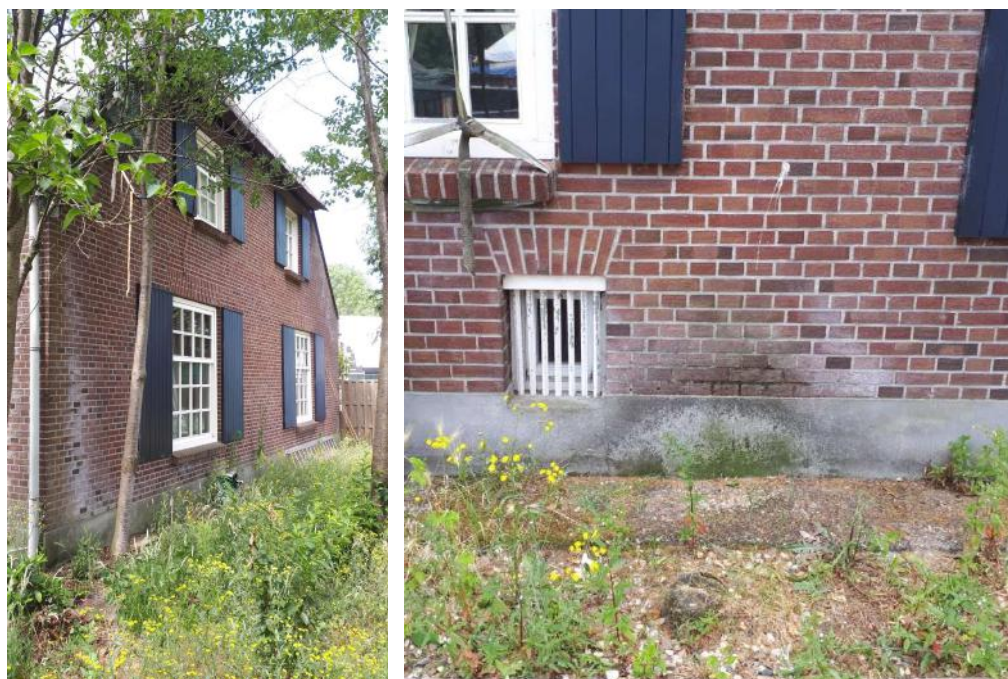
Figuur 9 - Oostgevel van de boerderij (links), detail metselwerk (rechts)
