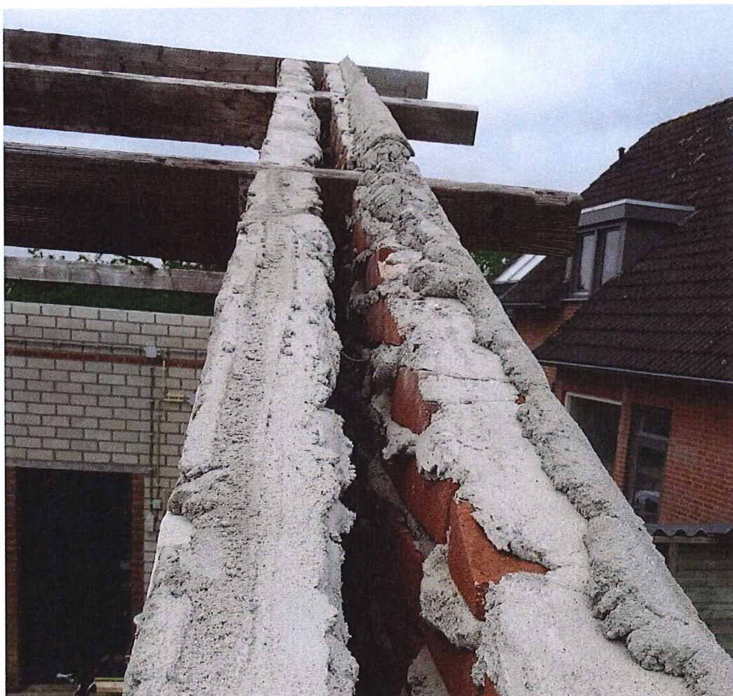
Foto 5, Detailfoto van een spouwmuur
