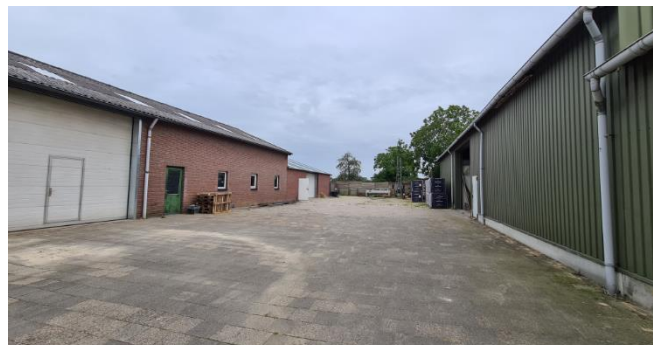
Figuur 5: Te slopen loods (rechts) en te verbouwen loods (links)
