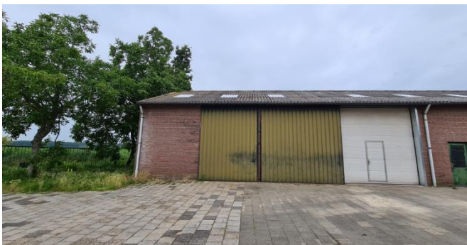
Figuur 4: Bakstenen loods
