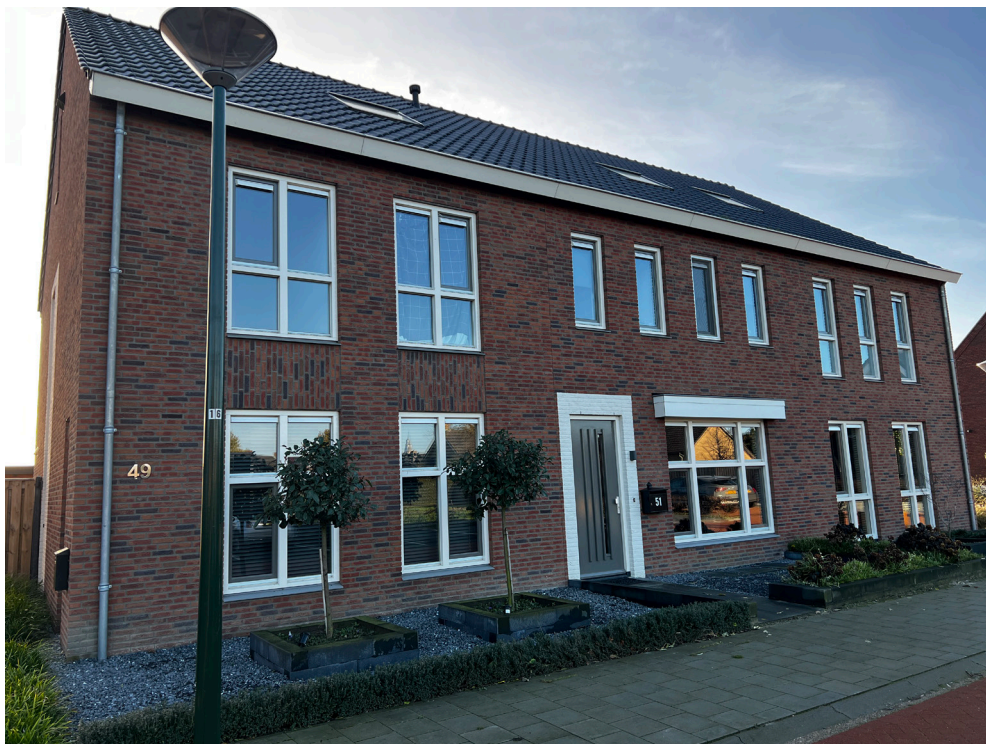
Rijwoningen Steenoven II fase 1
