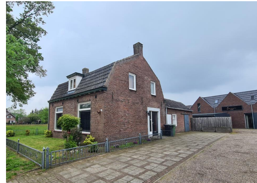
Figuur 9: Woning aan de Morgenstraat 29, gezien vanuit het oosten
