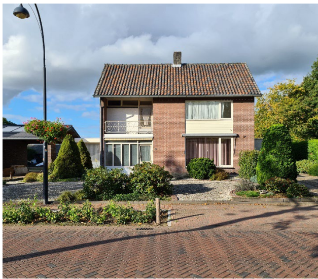
Zicht op huidige woning Antoniusstraat 15
