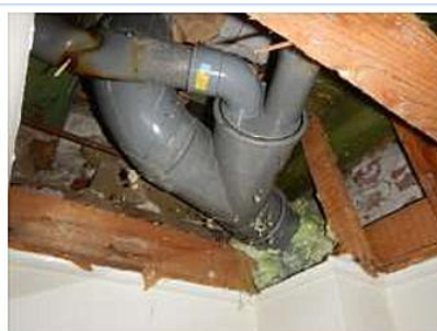
Riolering en ontluchting van pvc
