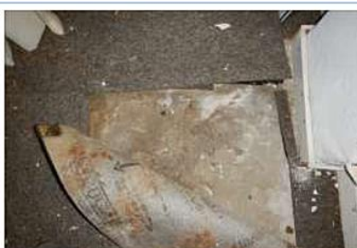
Tapijttegels op betonvloer
