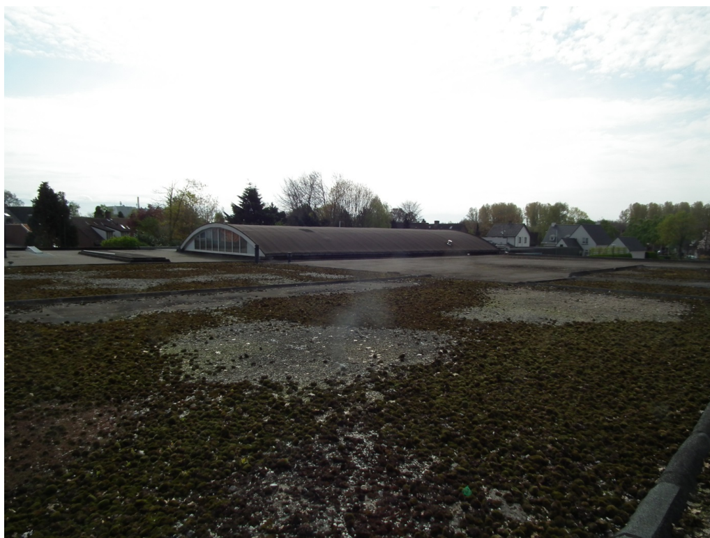
Figuur 2 De planlocatie is vrijwel geheel bebouwd met een opslagruimte/magazijn. Het platte bitumen dak is grotendeels begroeid door mossen.
