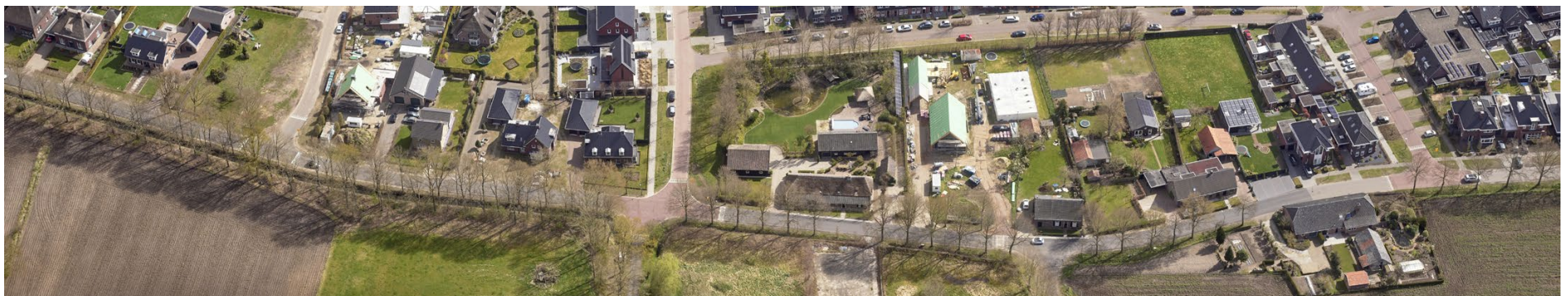
Luchtfoto van het dorpslint Voorbolst in Erp. Elke woning is uniek. Nieuwe bebouwing moet in maat, schaal en korrel aansluiten bij deze karakteristiek (Slagboom en Peeters luchtfotografie, 2022).
