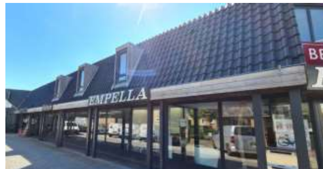
Figuur 5: Het plangebied gezien vanuit het noorden
