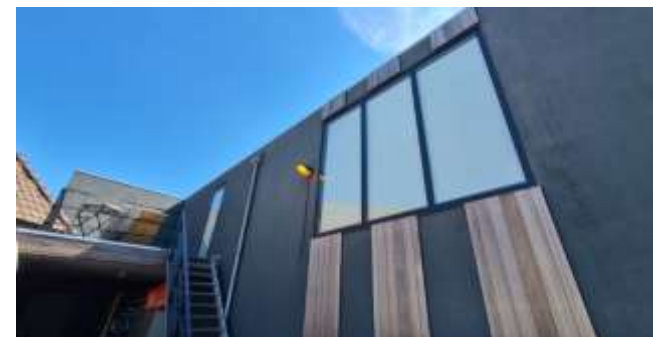
Figuur 5: Noordwesthoek van het gebouw
