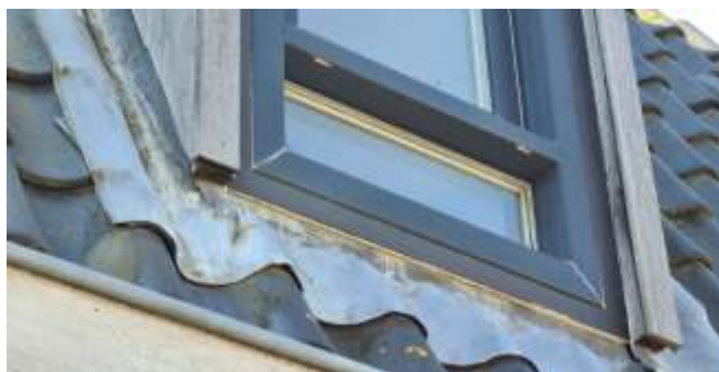
Figuur 7: Detailopname van lood rond dakkapel
