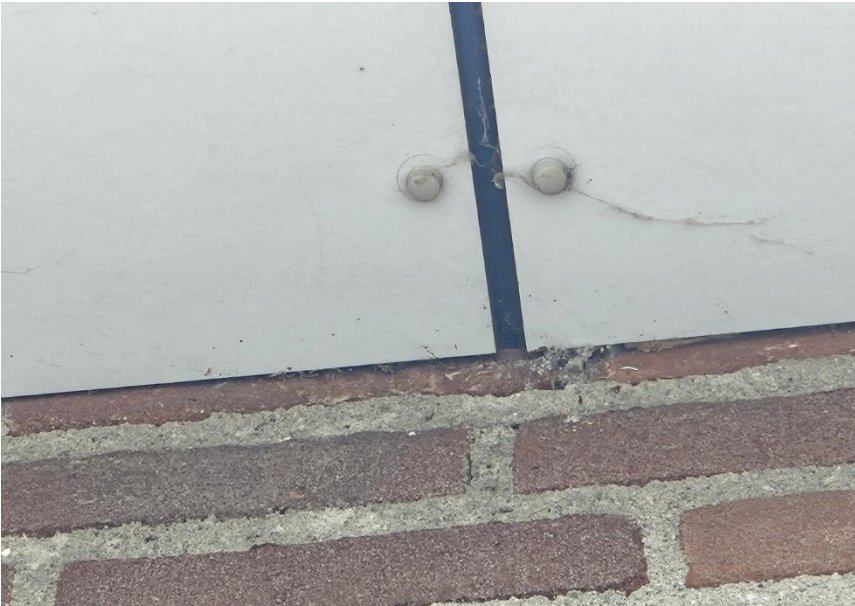
Figuur 13: Detailopname dakrand
