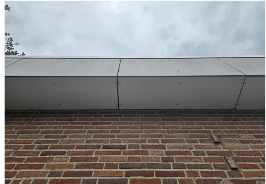
Figuur 12: Detailopname dakrand
